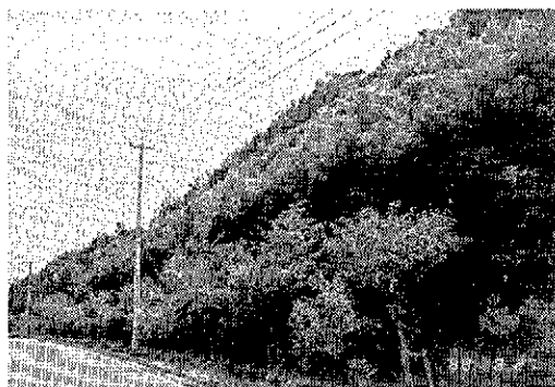
走行路切土斜面（7 年後の現在）
