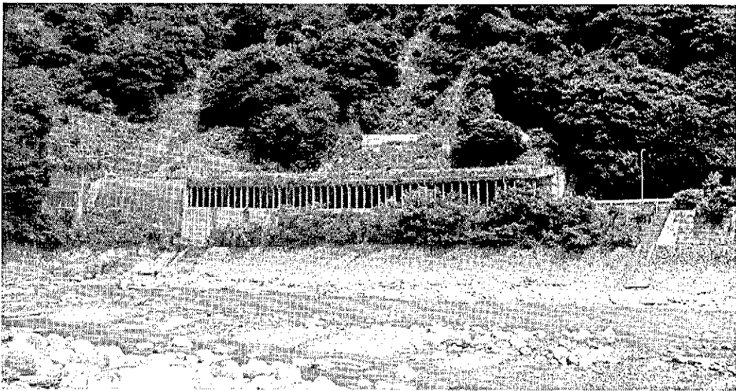
事例47 洞門の対岸からの景観に配慮した例—宇奈月ダム—
