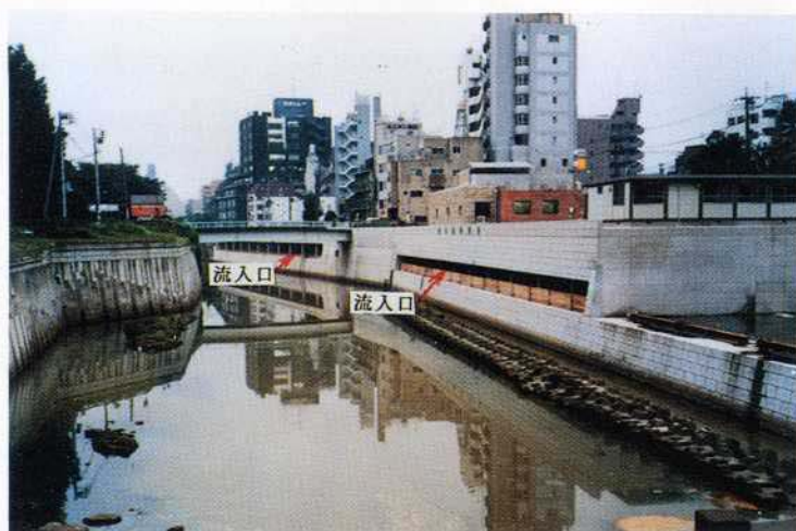
写真 4 - 12 目黒川船入場調節池（東京都目黒区）
