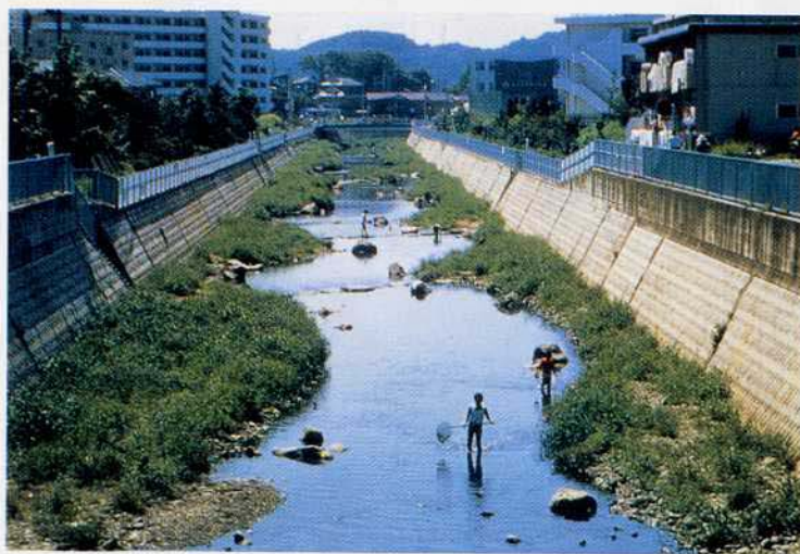
いたちがわ 写真 4 - 5 低水路の整備に工夫して自然の川らしさを回復した狹川
