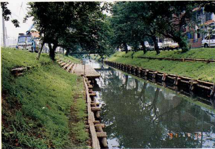
写真 3 - 1 魚類の生息環境や景観に配慮した新河岸川 しんがしがわ の事例(埼玉県川越市)
