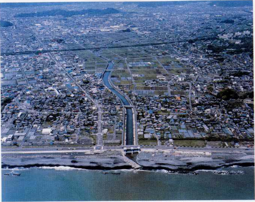
写真 4 - 3 放水路の開削による市街地の防衛 (大谷川放水路：静岡県静岡市)
