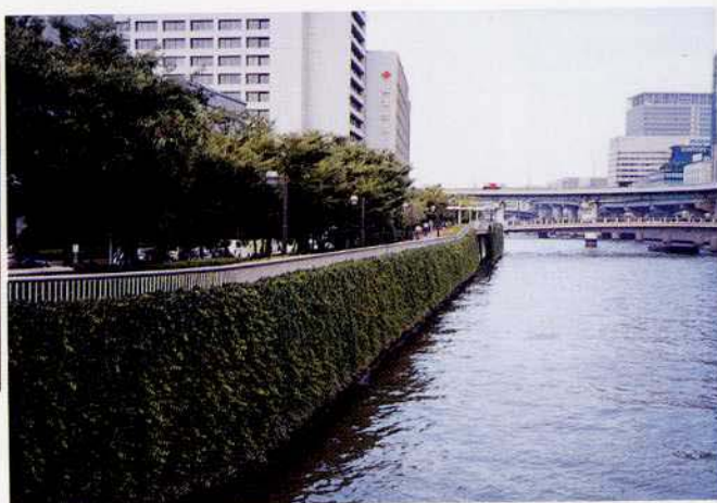
写真 4 - 7 ツタにより護岸を緑化した堂島川 (大阪市中央区)
