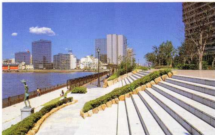
写真 4－1 近代的なまちなみと調和させた水辺を創出した隅田川大川端の緩傾斜堤防（東京都中央区）
