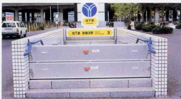
写真6-6 地下鉄出入口の防水板（神奈川県横浜市）
