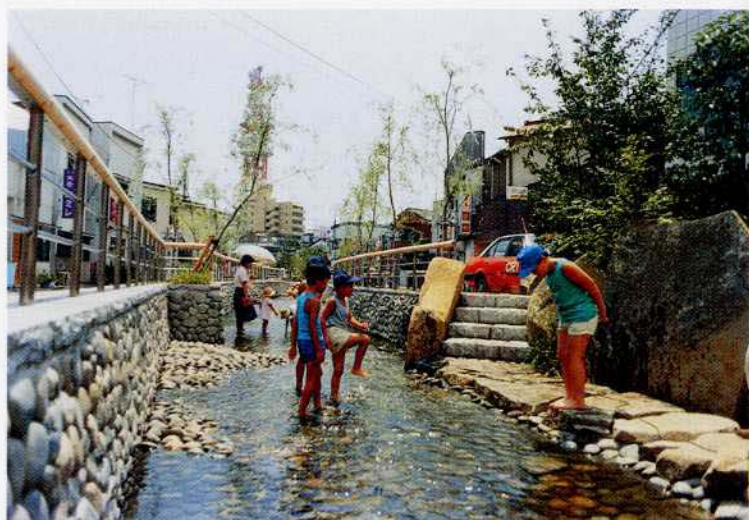
写真4-6 うるおいのある水辺空間の創出に配慮した釜川の改修 (栃木県宇都宮市)
