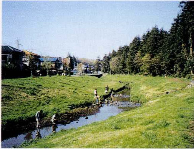
周辺の樹林帯の保全と一体となって整備された河川の事例
