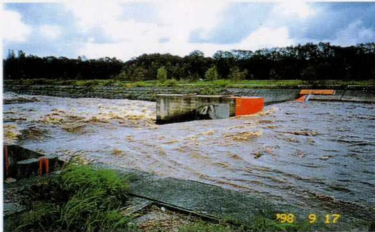
写真-5.5.2 段落ち部の水面形
