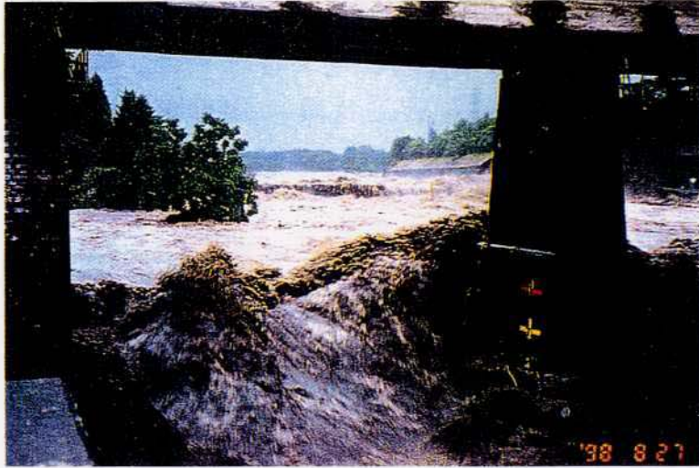
写真-5.5.1 橋脚設置付近の水面形
