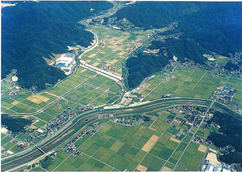
写真4.1 小野川放水路（近畿地建豊岡工事事務所提供）
