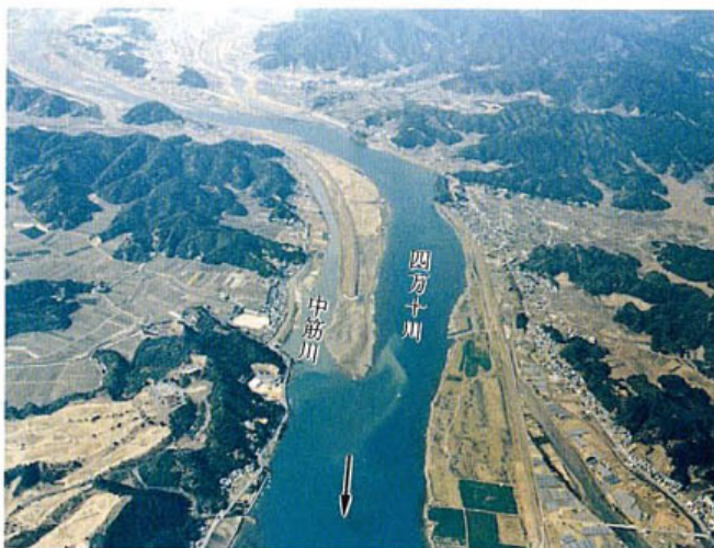
写真 4.2 中筋川の背割堤 (現況) (四国地建中村工事事務所提供)
