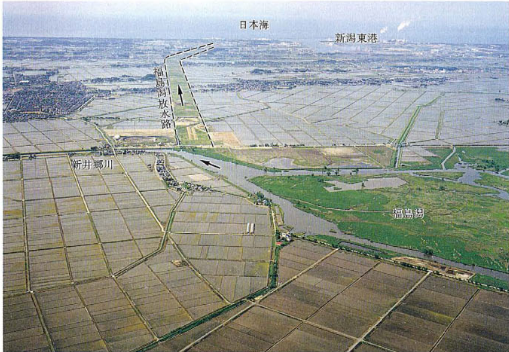
写真 4.4 新井郷川福島湾放水路（新潟県土木部提供）
