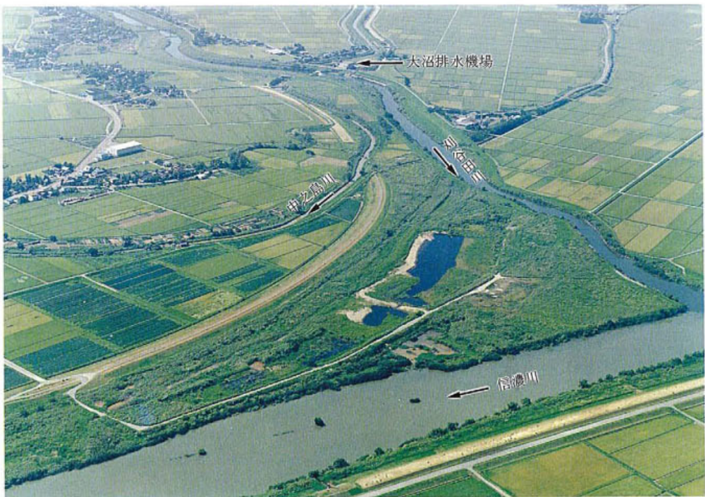
写真 4.3 現在の阿谷田川と中之島川の合流状況 (北陸地建信濃川下流工事事務所提供)
