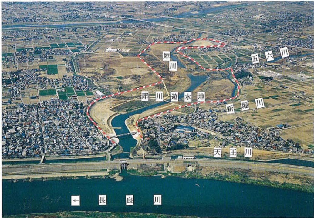
写真 4.6 犀川遊水地 (中部地建木曾川上流工事事務所提供)
