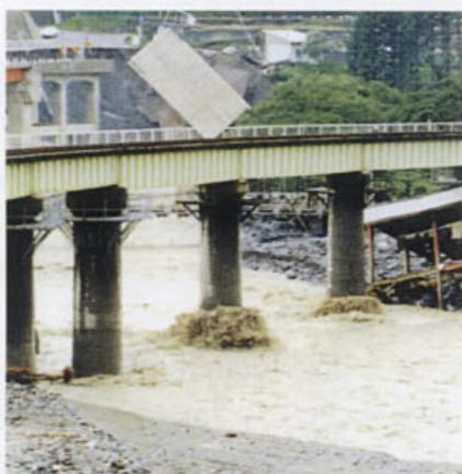
写真3-1 出水時における橋脚周辺の水面状況（姫川）
