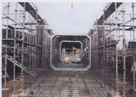
鉄筋コンクリート函体 (九州地方建設局)
