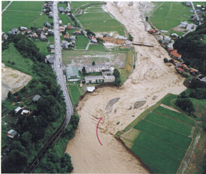
写真 2-2 河岸の侵食被災事例
