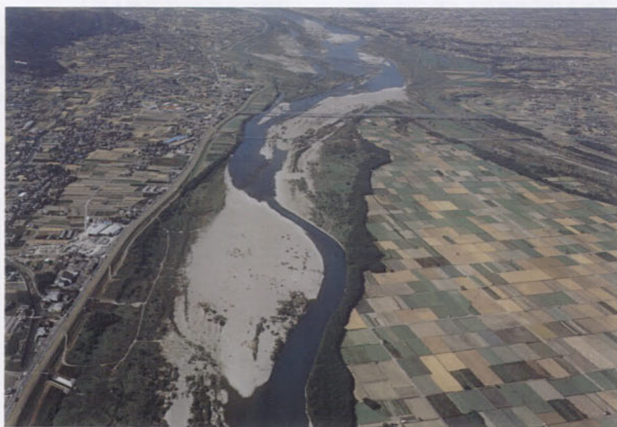
写真-2 セグメント2-1に分類される河道 (吉野川・32～33 km 付近, 四国地方建設局提供)
