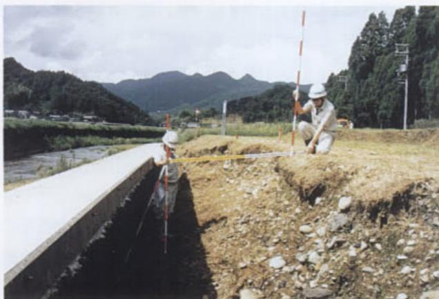
写真 2-6 法覆工背後の土砂流出事例
