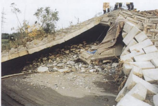
写真 2-7 連節型ブロック背面土砂の流出事例
