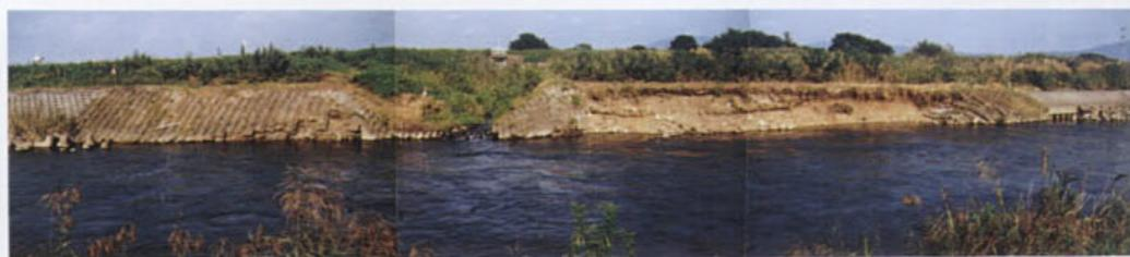
写真2-4 河岸侵食によるすりつけ護岸の被災事例
