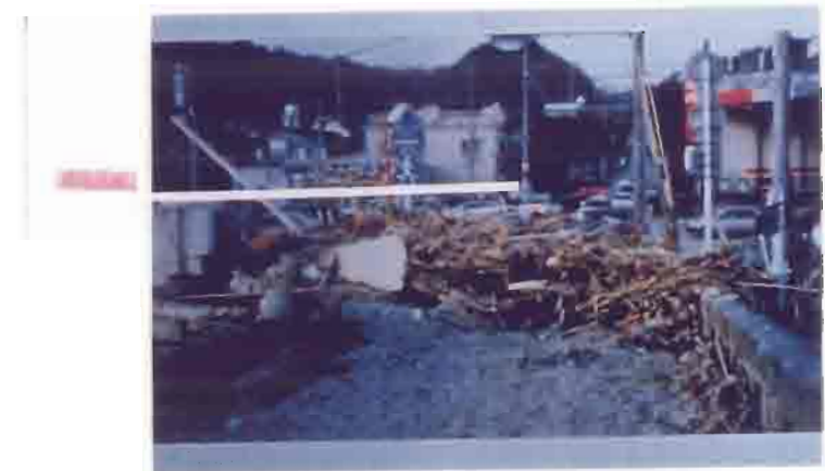
玉江橋(市道)橋面上に堆積した流下物
