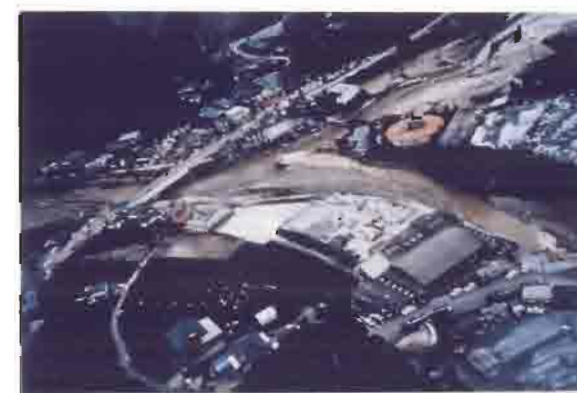
平成5年8月6日の撮影 護岸が壊れた甲突川 鹿児島県市小山田
