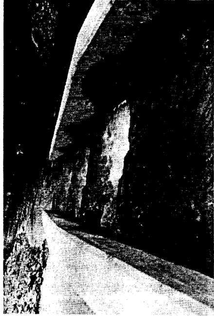
写真 4. 1 (2) 魚道上流から下流を望む
