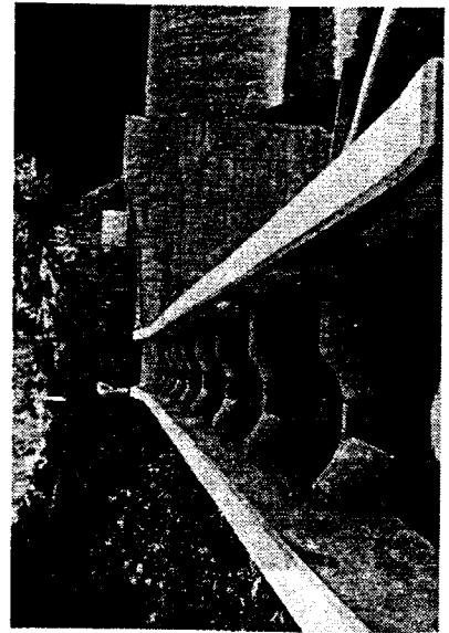
写真 4. 7 (4) 魚道内部構造(下流から上流を望む)
