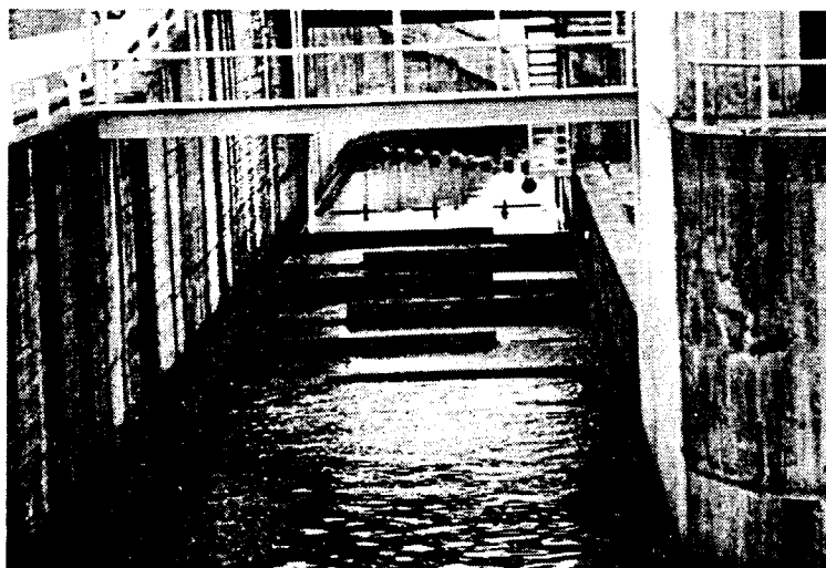
写真 4.17 (2) 魚道の状況 ①
