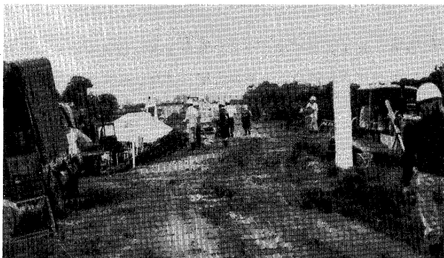
写 5-9 工事中道路の使用例
