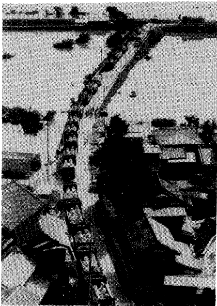
ブロックの搬入状況
