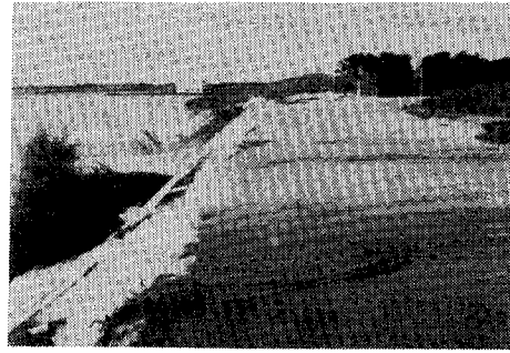
写 5-3 越水からの破堤状況その2
