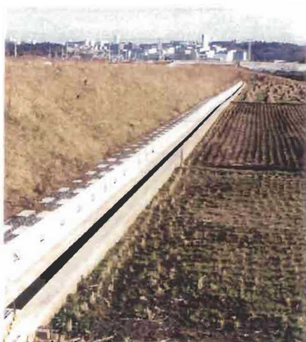
写真・資2. 3 完成直後のドレーン工の状況
