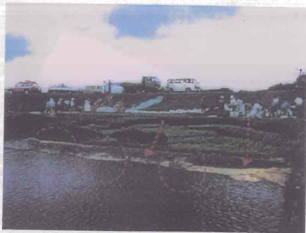
写真2 浸透による堤防被害の事例
