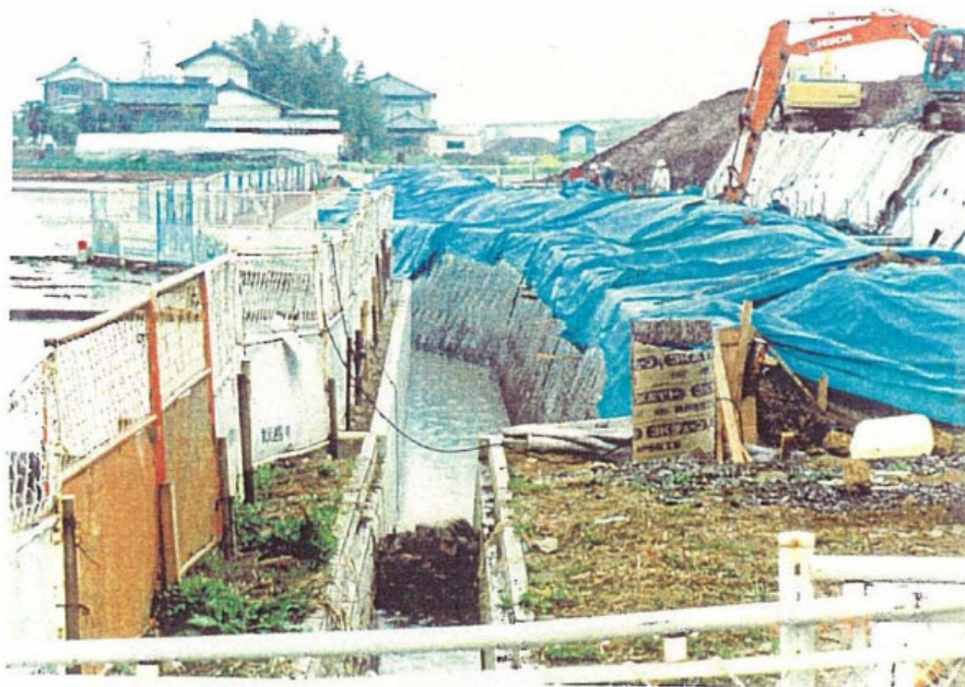
写真-資 2.2 堤脚水路の状況
