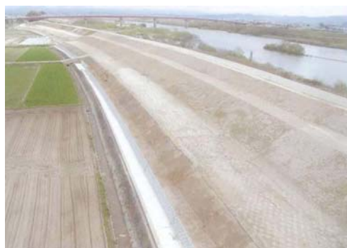
写真-資 2.12 施工後
