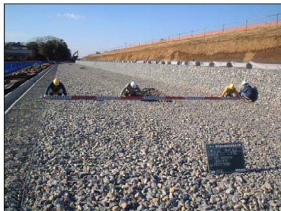
写真-資-2.9 ドレーン材料の敷設
