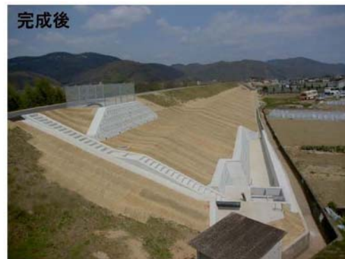
写真-資 2.20 施工後
