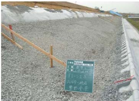
写真-資 2.10 フィルター砕石整形
