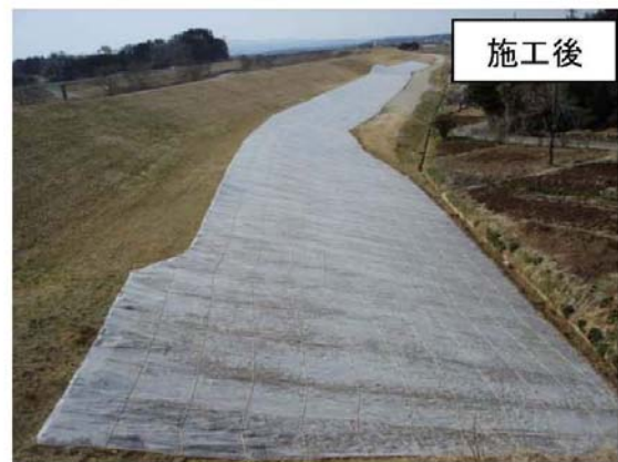
写真-資 2.6 施工後
