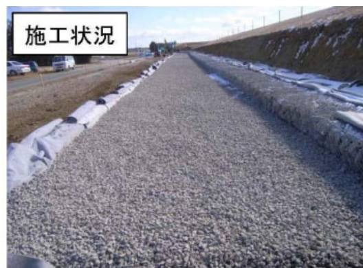
写真-資 2.7 施工中
