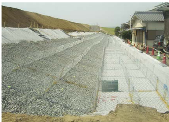
(2) ドレーン工の施工状況
