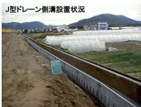
写真-資 2.21 施工中
