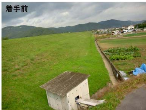
写真-資 2.19 施工前
