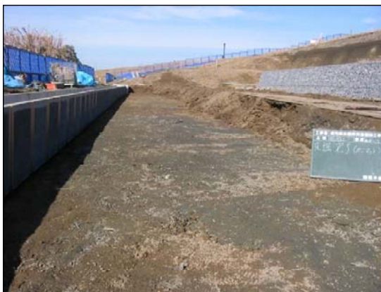
写真-資 2.8 床掘り完了
