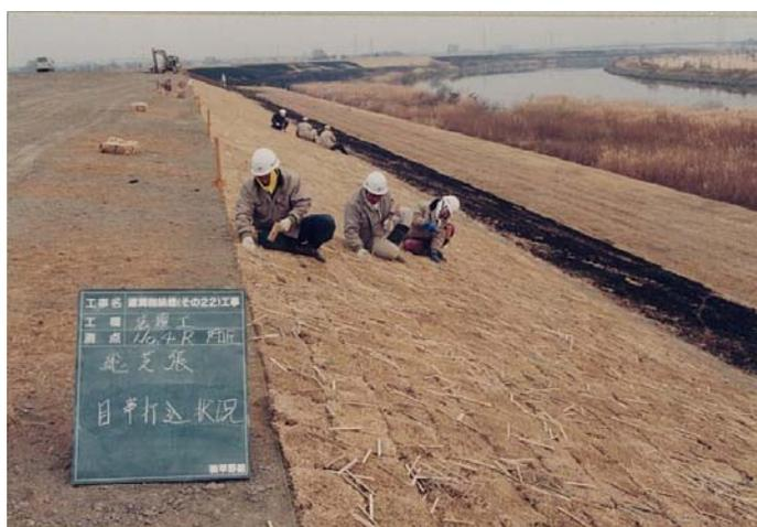
写真7.1.20 目串打ち込み状況（関東地方整備局）
