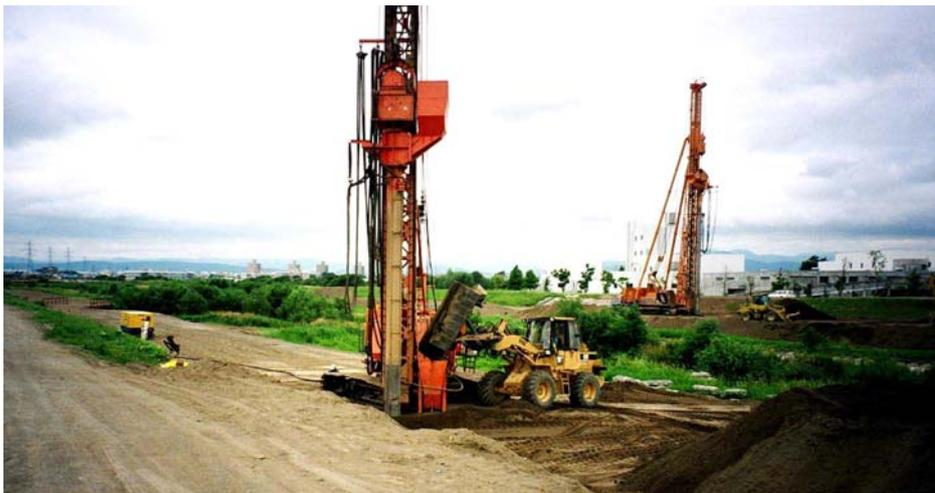
写真 7.3.1 動的締固め工法の施工状況
