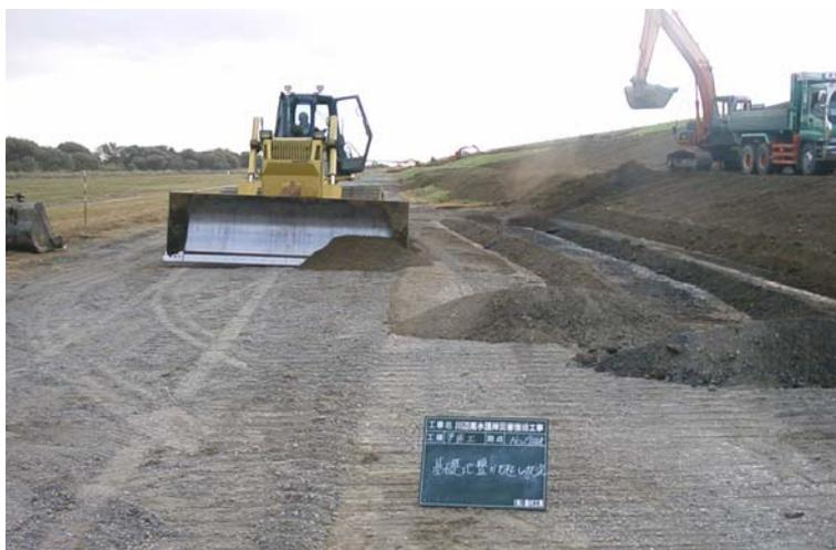
写真 7.2.4 基礎地盤の掻き起し状況
