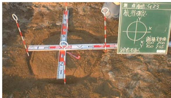
写真 7.3.3 杭径確認状況 例
