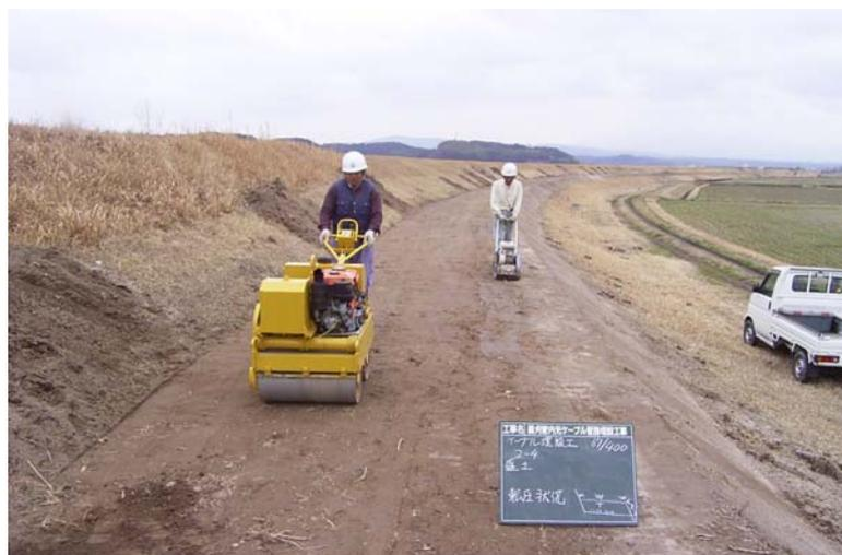
写真7.1.18 小型振動ローラによる締固め状況 (九州地方整備局)
