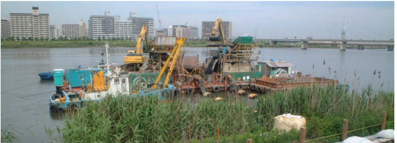
写真 7.4.7 空気圧送方式による搬送状況
