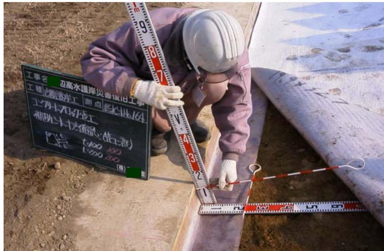
写真 7.2.1 端部のシートの重ね状況
