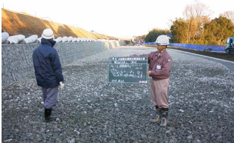
写真 7.2.5 川裏のり尻ドレーン部の施工状況
