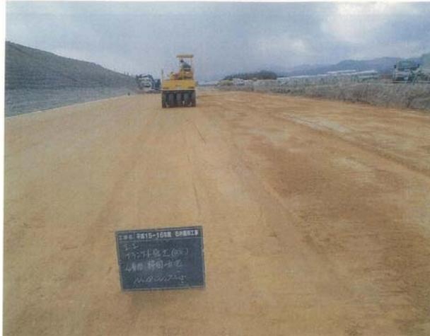
写真 7.2.12 ブランケット盛土の締固め状況
