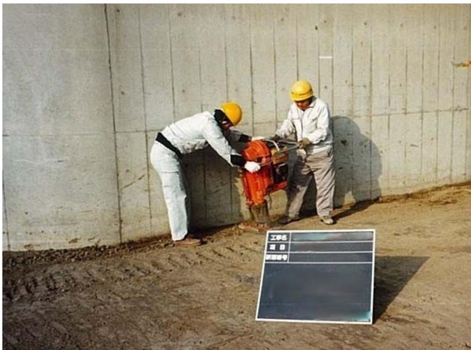
写真7.1.19 構造物周辺盛土の締固め(関東地方整備局)
