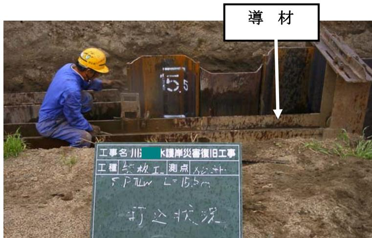
写真 7.2.10 鋼矢板打設時の導材設置状況
