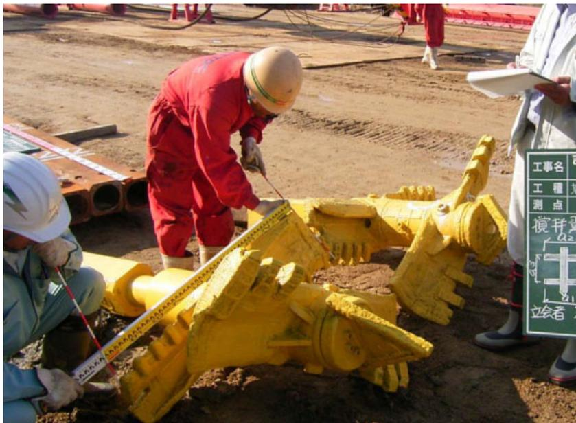
写真 7.3.6 攪拌翼の形状確認状況
