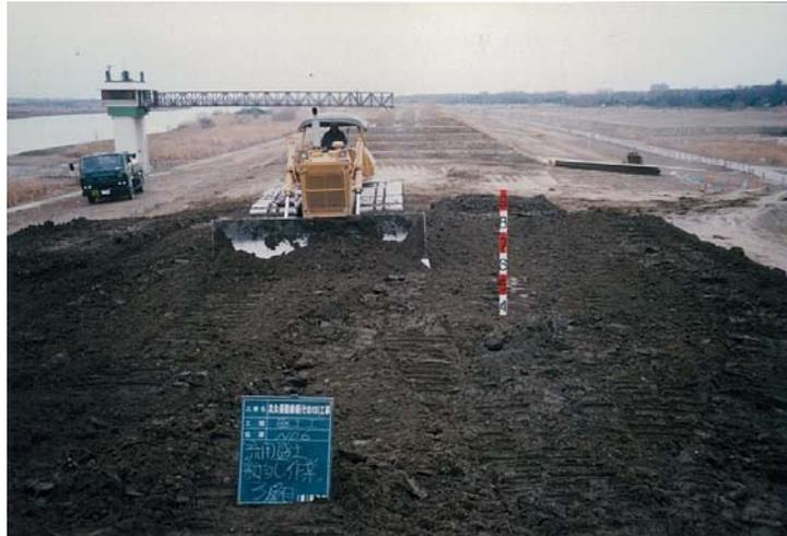
写真7.1.13 ブルドーザによる敷均し作業状況(関東地方整備局)
