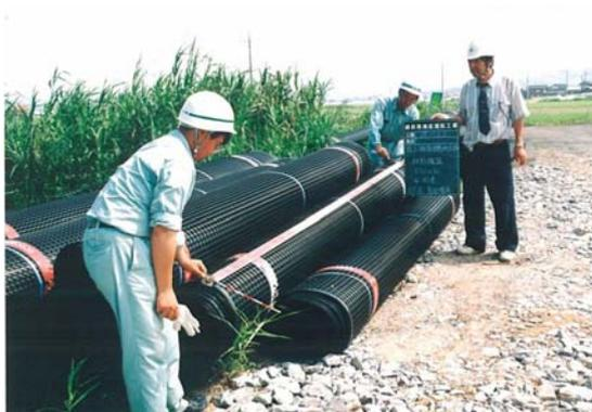
写真 7.1.26 補強材の材料検収状況
