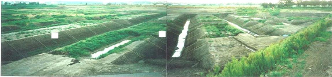
写真 7.1.3 トレンチ掘削状況
