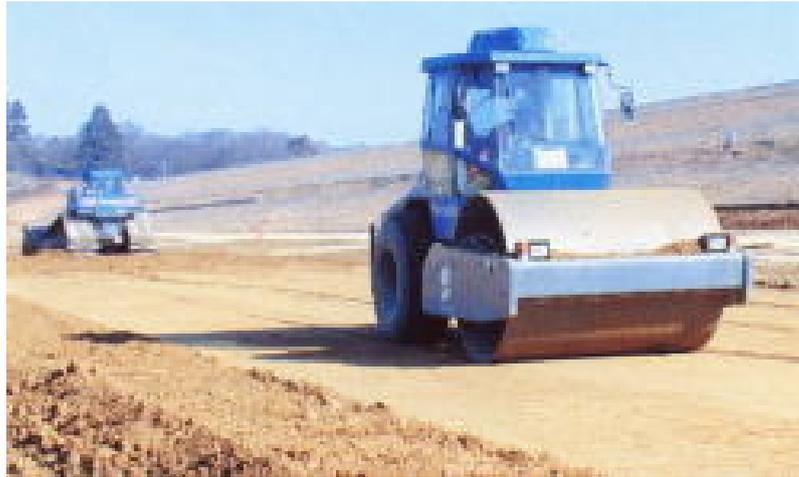
写真7.1.16 振動ローラ(11t級)による締固め状況
