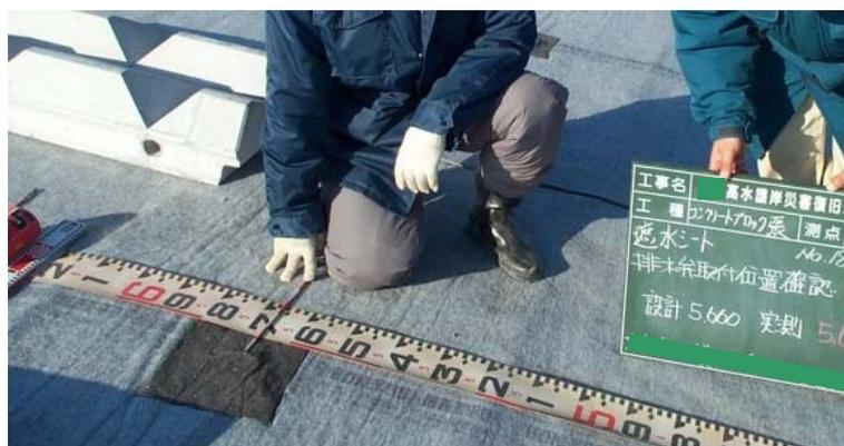
写真 7.2.2 遮水シート用ウィープホールの設置状況
