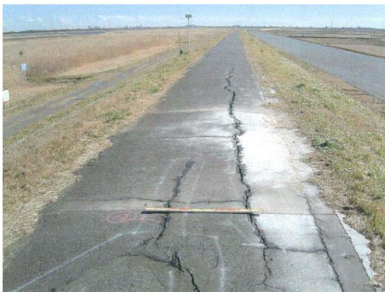
写真 7.1.32 腹付け盛土により天端に発生した亀裂の事例
