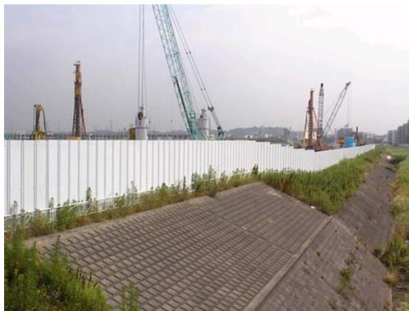
写真 7.6.1 立入禁止柵の設置状況
