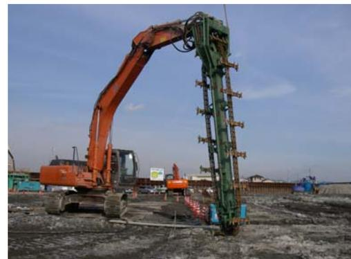
写真 7.1.25 トレンチャー式攪拌機
