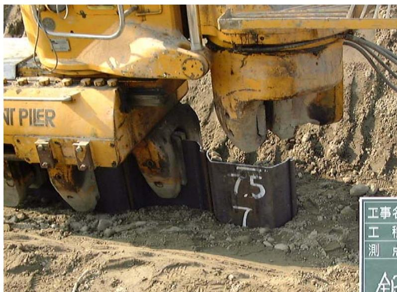
写真 7.2.9 油圧式杭圧入・引抜機による打ち込み状況
