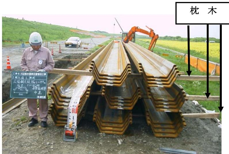
写真 7.2.8 搬入された鋼矢板の保管状況
