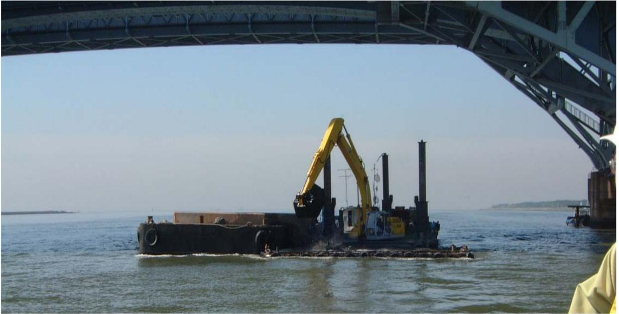
写真 7.4.6 土運船による運搬状況
