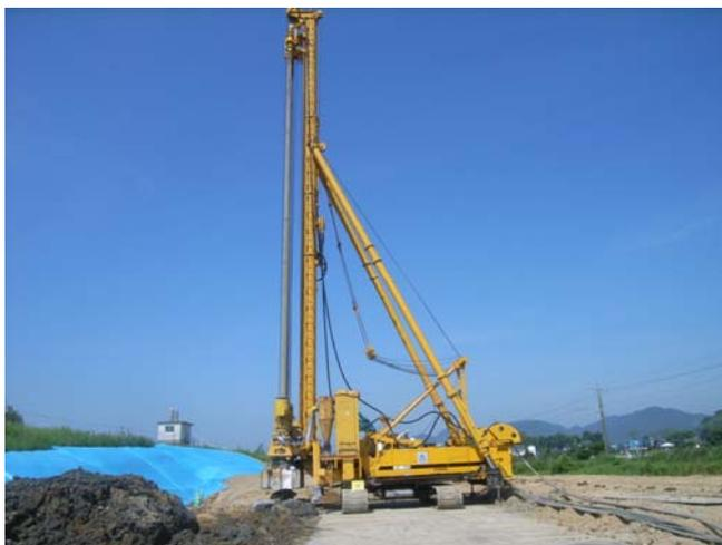
写真 7.1.29 深層混合処理工法(九州地方整備局)
