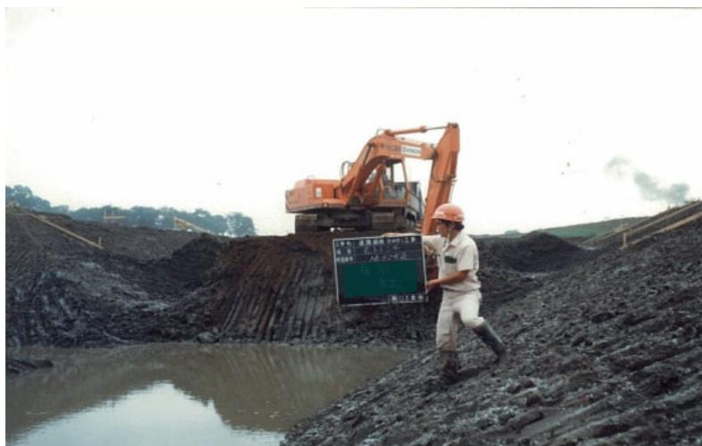
写真 7.1.2 トレンチ掘削状況
