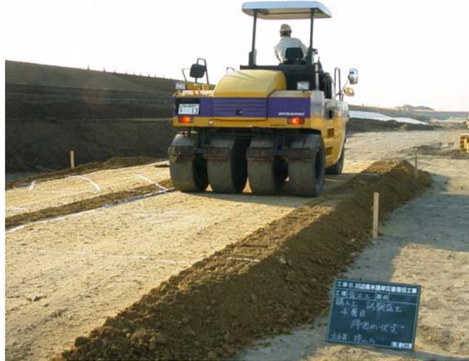
写真7.1.15 タイヤローラによる締固め状況（関東地方整備局）
