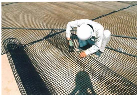
写真 7.1.28 補強材のジョイント部の施工状況
