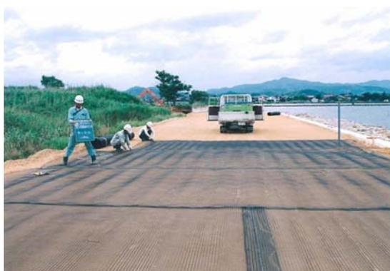
写真 7.1.27 補強材の敷設状況
