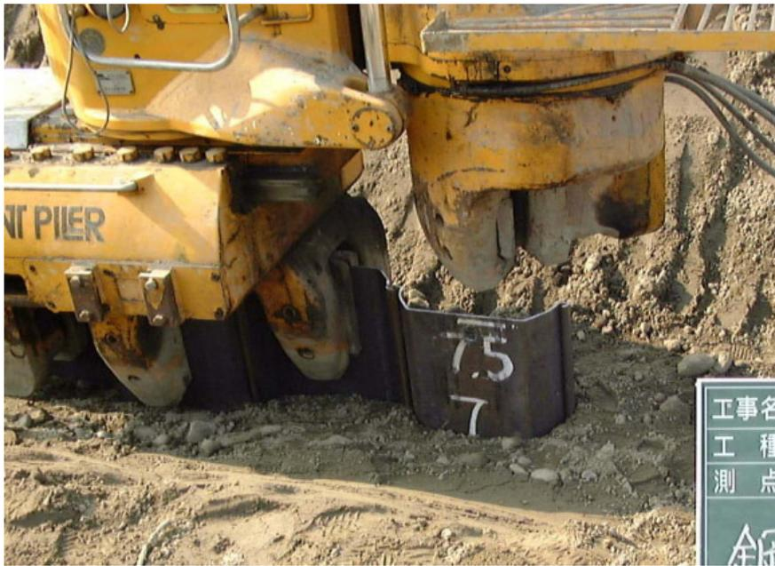
写真 7.3.13 油圧式杭圧入・引抜機による打ち込み状況
