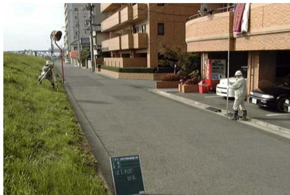
写真 7.3.4 堤内地盤高の測定状況
