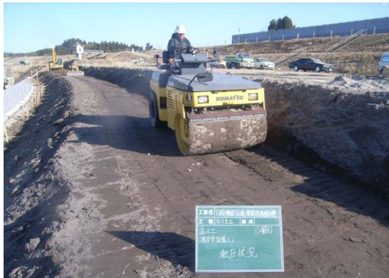
写真7.1.17 振動ローラ(4t級)による締固め状況 (九州地方整備局)
