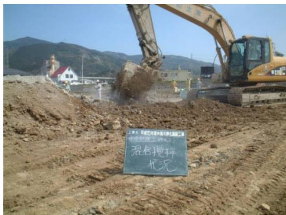
写真 7.5.2 混合攪拌状況
