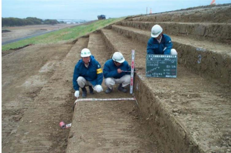
写真 7.1.9 段切の幅・高さの確認状況（関東地方整備局）
