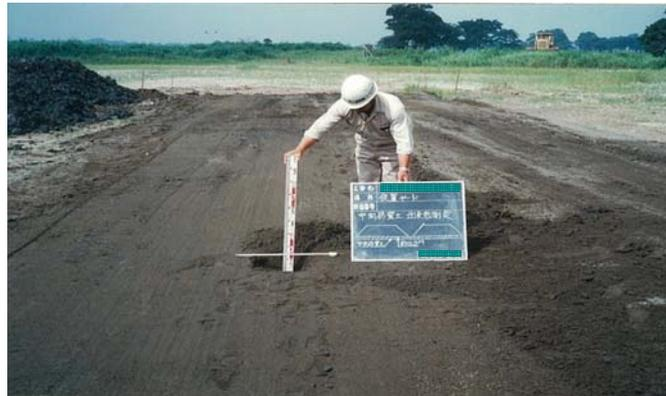
写真 7.1.4 仮置きヤードのサンドマット敷設状況
