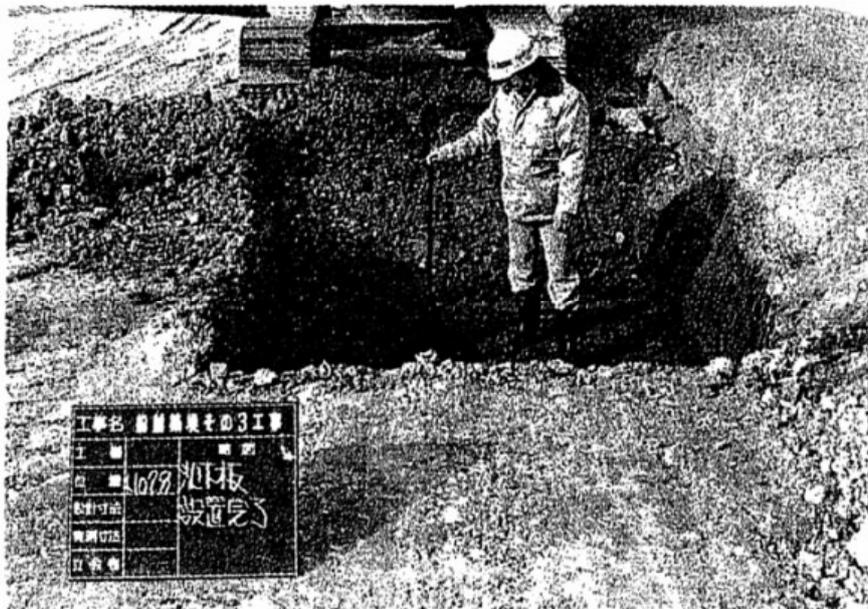
写真 5.7.1 沈下板の設置状況 (東北地方整備局)
