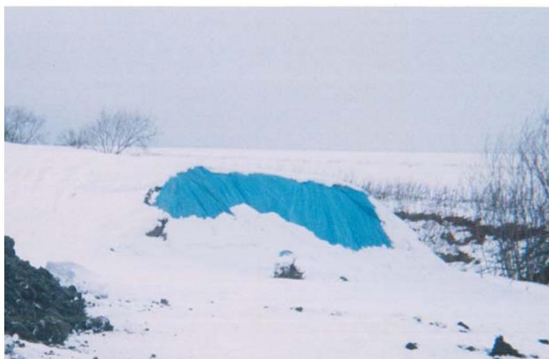
写真 5.3.1 積雪地における冬期の堤体材料養生状況
