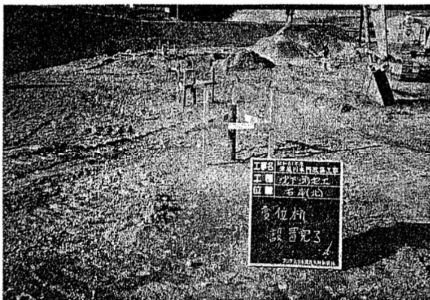
写真 5.7.2 変位杭の設置状況（中部地方整備局）
