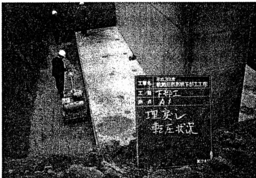
写真 4.3.17 構造物周辺の埋戻し、転圧状況(中部地方整備局)
