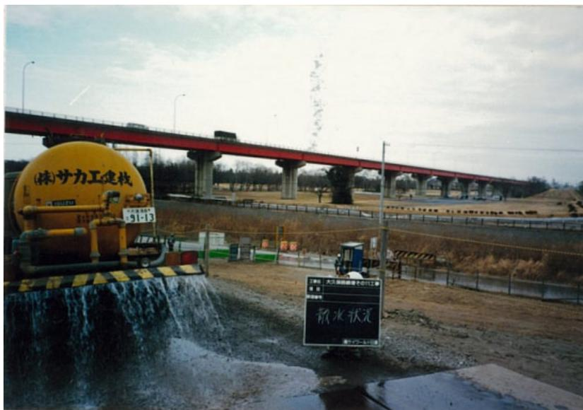
写真 4.3.2 工事用道路の防塵のための散水（関東地方整備局）
