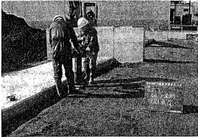
写真 4.3.18 タンパによる構造物周辺の埋戻し、転圧状況
