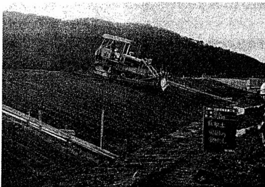
写真 4.3.11 ブルドーザによるのり面の締固め状況（中国地方整備局）
