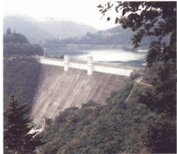
〔小河内ダム：東京都〕 樹木によりフーチング部が遮蔽され、ダム本体のシルエットをくっきりと浮き立たせている。
