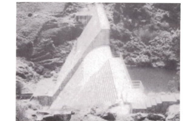
(WEST VARAHAPALLAM DAM (INDIA)) マッシュでシンプルな形状の表面に、細かいピッチの階段模様を施して、適度な変化を与えている。
