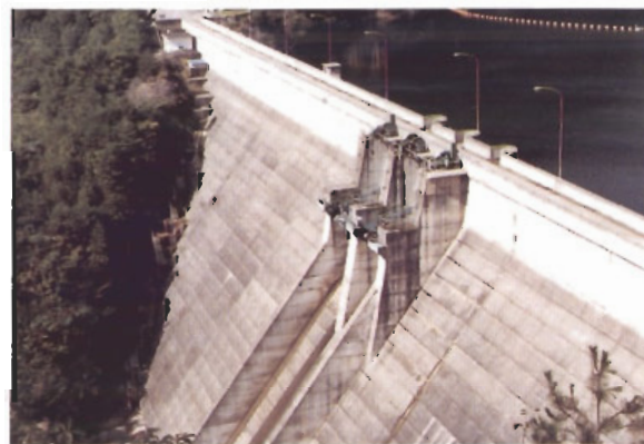
〔生野ダム：兵庫県〕 ダム天端に構造物が突出せず、照明の配置も規則的である。
