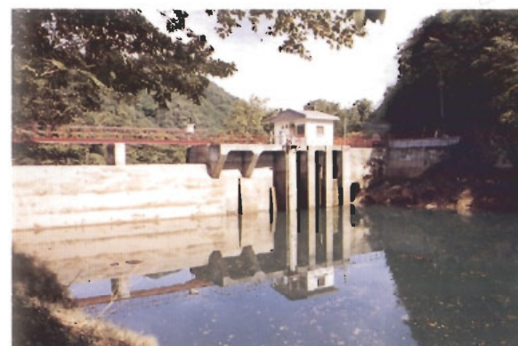
ゲートハウスの規模が全体のバランスをくずしている。また、高欄等に対する配色が適切でない。
