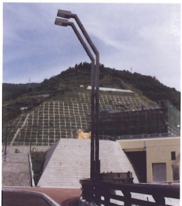
(浅瀬石川ダム：建設省・東北地方建設局) 配色を高欄に合わせてあり、両者が一体的である。また、シンプルなデザインである。
