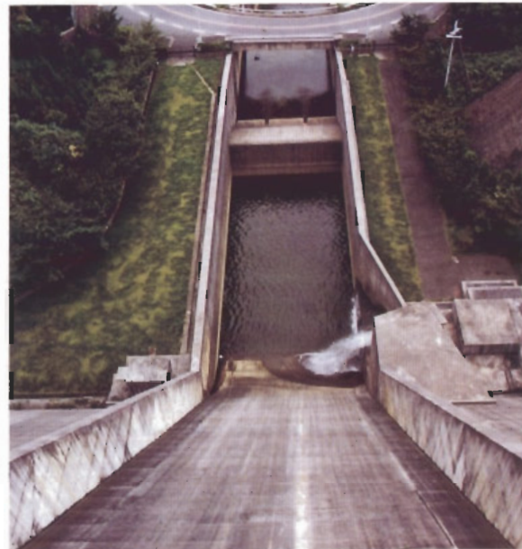
(天理ダム：奈良県) 埋め戻しにより地山への取付部がコンパクトに収まっている。 連続感がある。
