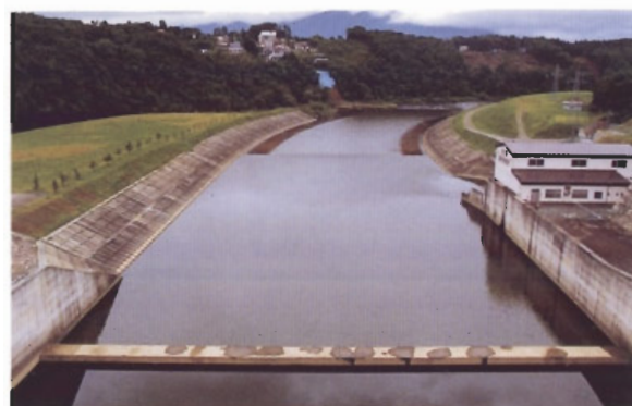
(御所ダム：建設省・東北地方建設局) 減勢工下流部に、地山となだらかに接合する護岸を施し、やわらかさを出している。
