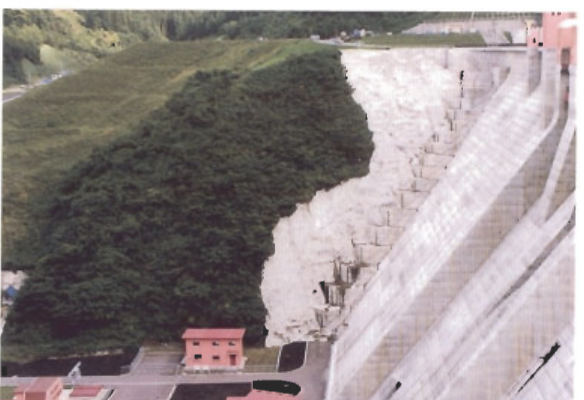
法面に吹き付けられたモルタルの白色が、地山にもダム本体にもなじまず、乾いた印象を与えている。
