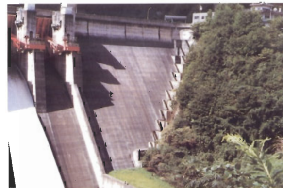
〔室生ダム：水資源開発公団〕 フーチングの高さ・太さが揃っている。また、管理用階段がフーチングと一体構造になっており、竹藪物の印象を緩和している。
