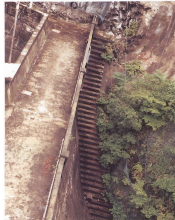
〔菅野ダム：山形県〕 フーチングの一段の高さを抑え、段数を増やしている例。このような細かいシマ模様により、ダムのシルエットが引き締められる効果がある。
