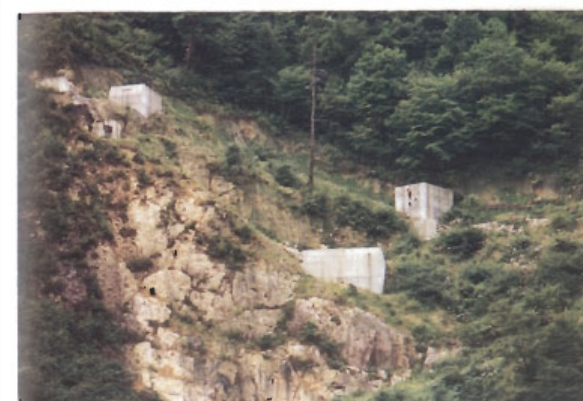
放置されたままの仮設備。周辺の露岩の中で、異様な存在となっている。
