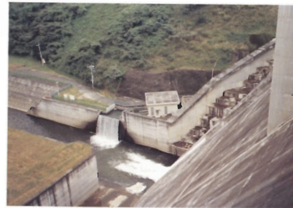
(桐生川ダム：群馬県) 利水放流を滝状に行っている。減勢工導流壁の全面を使えば、景観面での効果はさらに高くなるであろう。
