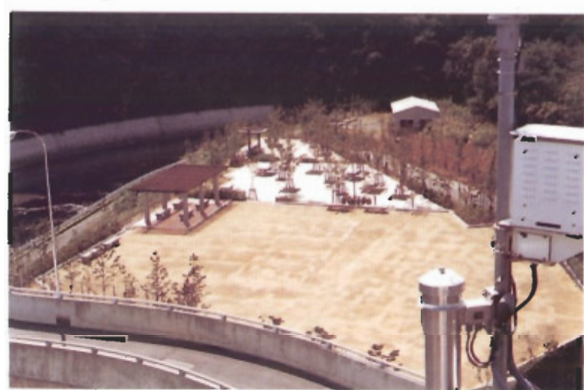
〔青野ダム：兵庫県〕 仮設備跡地の平坦地を園地として整備している例。
