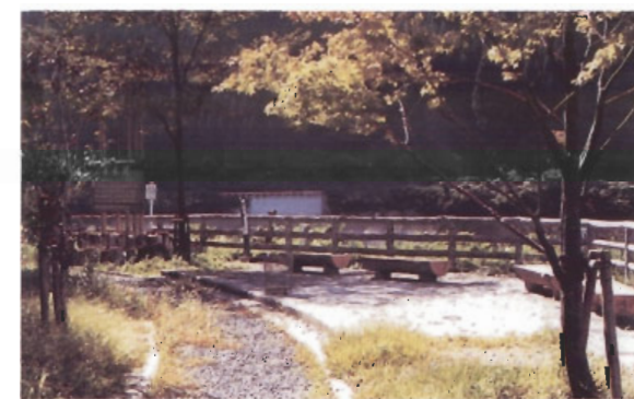
(引原ダム：兵庫県) ベンチやフェンスに樹木をあしらって自然の景観になじませている。
