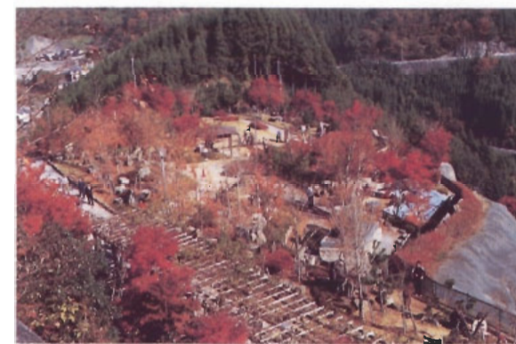
(邪馬溪ダム：建設省・九州地方建設局) 秋の紅葉の美しさがよく演出されている庭園的な整備である。
