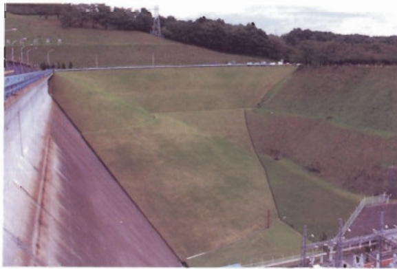
〔四十四田ダム：建設省・東北地方建設局〕 種子吹付け法面工により、緑化が始まった法面。
