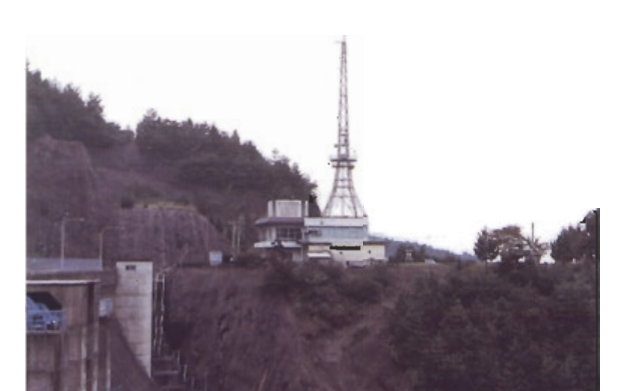
通信用鉄塔の規模が管理棟に比べ大きすぎ、バランスを欠いている。
