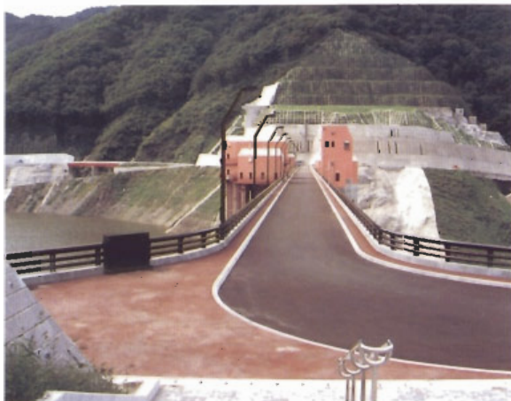
（浅瀬石川ダム：建設省・東北地方建設局） 高欄が取付道路から貫かれ、強い連続性が得られている。照明設備と同色（ブロンズ）の配色によって、まとまりのある空間を生み出している。歩道部を高くし、別舗装としていること、親柱がつけられていることなども景観を引き締める効果を与えており、また歩道の設置は、視点場としての機能を高めている。
