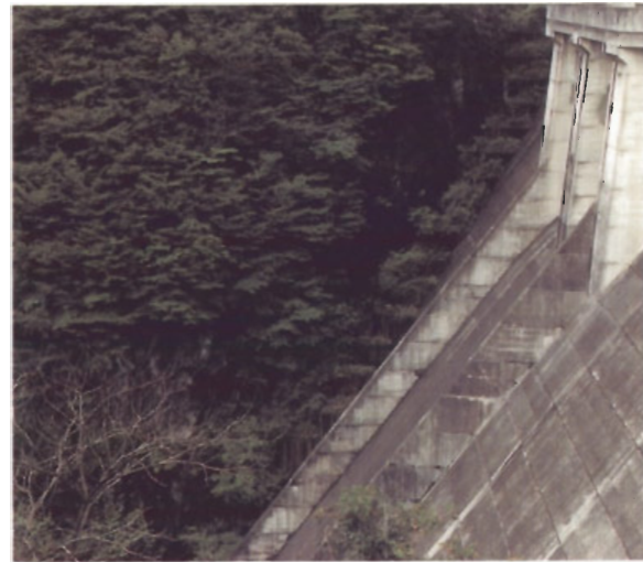
〔西荒川ダム：栃木県〕 草本の侵入により、フーチング部が地山と同化しつつある例。フーチング部そのものも露岩の色と同化している。
