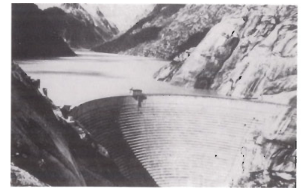
(SPITALLAM DAM (SWITZERLAND)) 下流表面を階段形状にしたアーチグラビティーダム。同心円状の線模様が統一感のみでなく緊張感を与えている。
