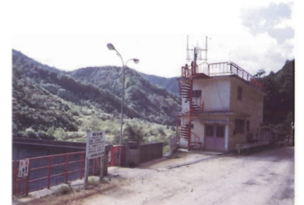
管理棟と周辺の施設との配色の統一感が見られない。
