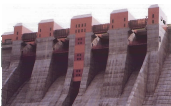
〔浅瀬石川ダム：建設省・東北地方建設局〕 ゲートハウス及び管理橋の配色が統一され全体として良く調和している。
