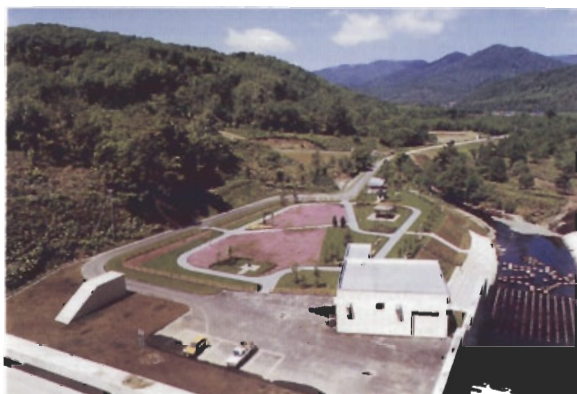
〔愛別ダム：北海道〕 減勢工部横の埋め戻し部分にあり、広場を兼ねた展望施設となっている。天端から俯瞰した時の色彩が美しく見える。
