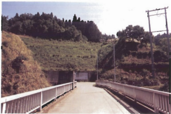
〔下条川ダム：新潟県〕 法面の緑化が進行している例。
