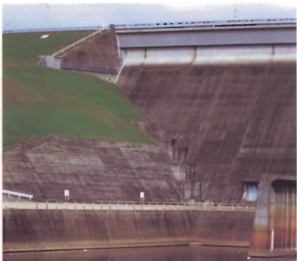
〔四十四田ダム：建設省・東北地方建設局〕 フーチングを設けている範囲が狭いため、違和感がやわらいでいる。
