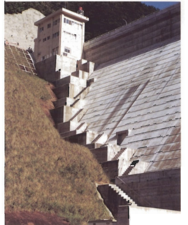
〔赤岩ダム：新潟県柏崎市〕 管理用階段がフーチングと一体構造となっており、すっきりと仕上がっている。
