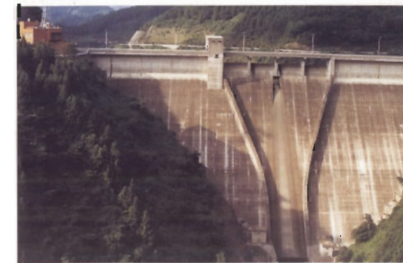
(島地川ダム：建設省・中国地方建設局) 導流壁がY字型の美しい形状となっている。
