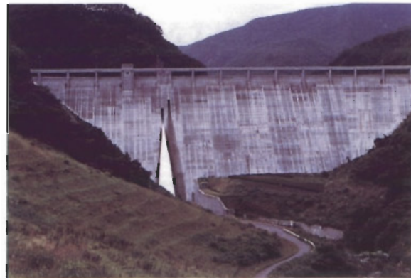
〔東山ダム：福島県〕 ゲートピアが等間隔に配置され、リズムカルで美しく見える。
