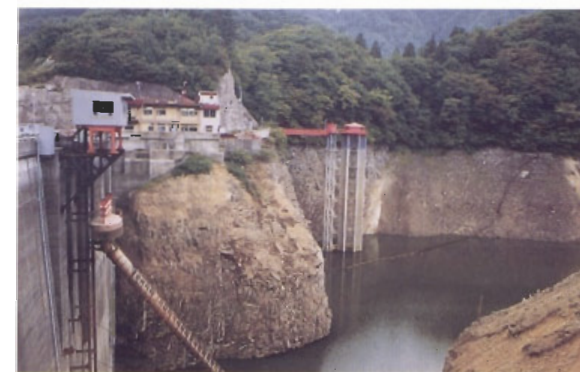
(素波里ダム：秋田県) スクリーンにより機械類の露出が抑えられ、シンプルに見せている。
