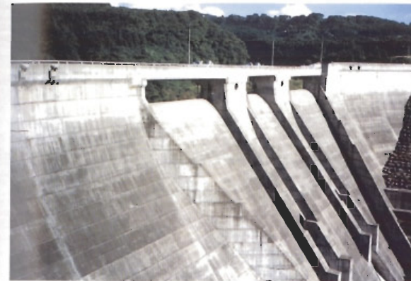
(月光川ダム：山形県) 接合部の曲面が下流表面の連続性を強め、ダムをなめらかな形にしている。
