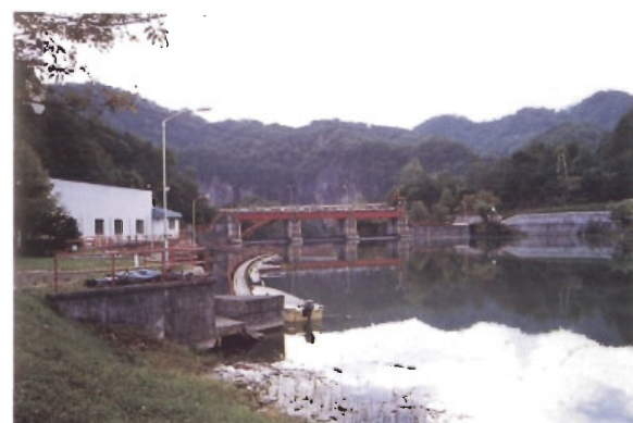
上流側の付帯設備等の配置に規則性がない。また、異なる材質が混在し、一体感に乏しい。
