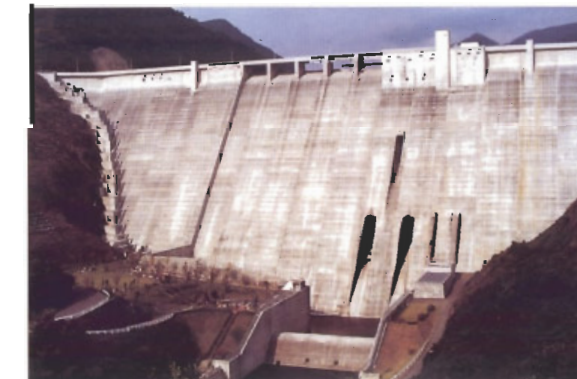
(蔵木ダム：建設省・九州地方建設局) 放流口下部を細長く掘り込んでおり、汚れが目立ちにくくなっている。
