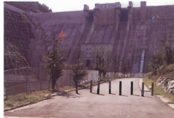
〔大町ダム：建設省・北陸地方建設局〕 ゲートピア等付帯設備がおおむねバランス良く配置されている。
