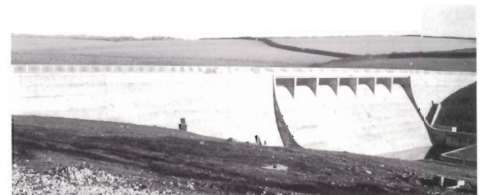
〔UPPER TAMAR DAM (ENGLAND)〕 幅広い導流部、長大な本体下流表面及び連続的な高欄が、このダムの持ち味であるスケールの大きさを引き立てている。
