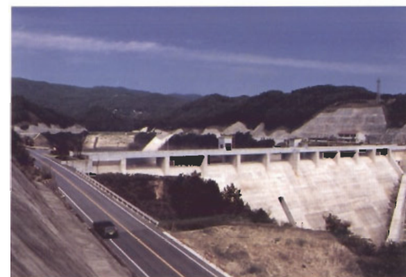
〔御調ダム：広島県〕 洪水吐の配置に規則性がある。
