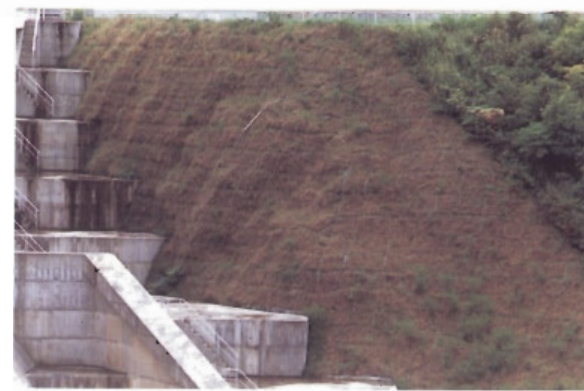
〔網取ダム：岩手県〕 法枠工と緑化工の2種の工法を用いているが、草本が活着し、違和感がやわらいでいる。やがて木本の侵入が始まる。
