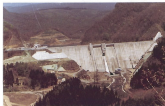
〔新中野ダム：北海道〕 天端の構造物が低く抑えられシルエットがすっきりして見える。
