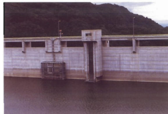
〔東山ダム：福島県〕 ピアに丸味がつけられており、やわらかい感じが出ている。
