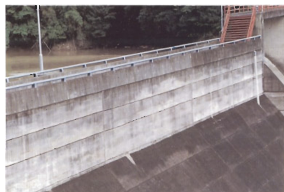
越流部で高欄の形状・材質・高さ・配色が急変し、連続性が断たれている。
