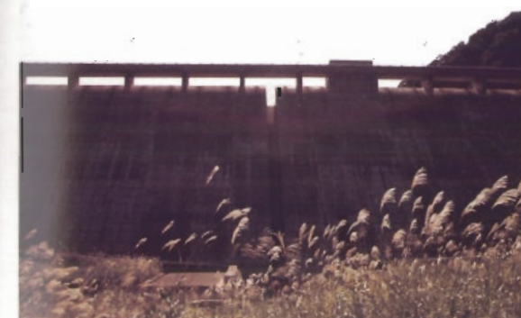
(正善寺ダム：新潟県) 常用洪水吐を掘り込んでいるため、汚れが目立ちにくくなっている。
