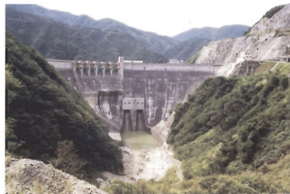
地山の植生が復元されず、ダムと周辺の自然との調和に欠ける。
