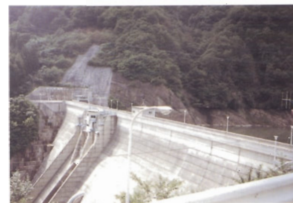
照明設備の配置に規則性がない。
