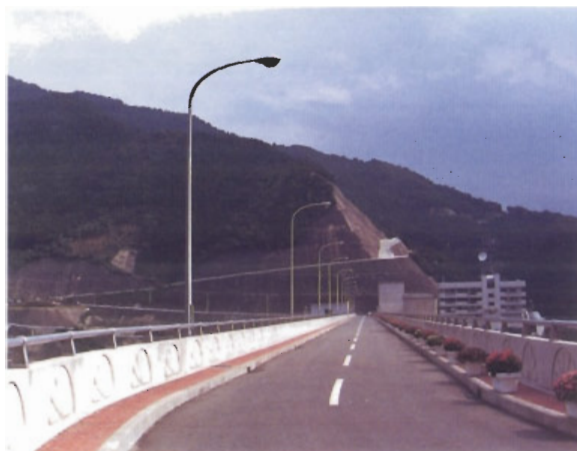
（厳木ダム：建設省・九州地方建設局） ハンドレールと照明設備とを同じ材質にするだけでも連続感が生まれる。両側とも基部が壁高欄であるが、模様をつけることによって単調さを抑えている。歩道部を車道と独立させて別舗装とすることにより、景観対象としても、視点場としても好ましい状態となっている。
