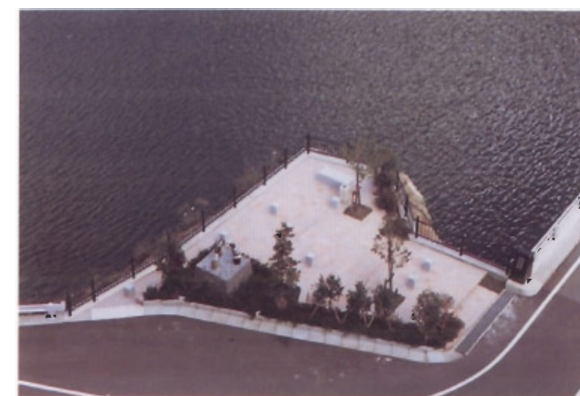
(本部ダム：佐賀県) 表面にカラータイルを敷きつめたもので、明るさを感じさせる。
