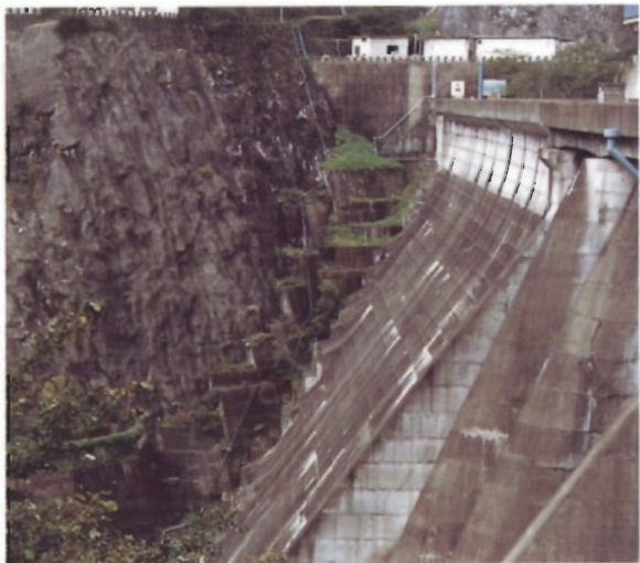
〔五十里ダム：建設省・関東地方建設局〕 蕨原ダムと同様に、フーチング部とダム本体とを曲線によってすりつけている例。
