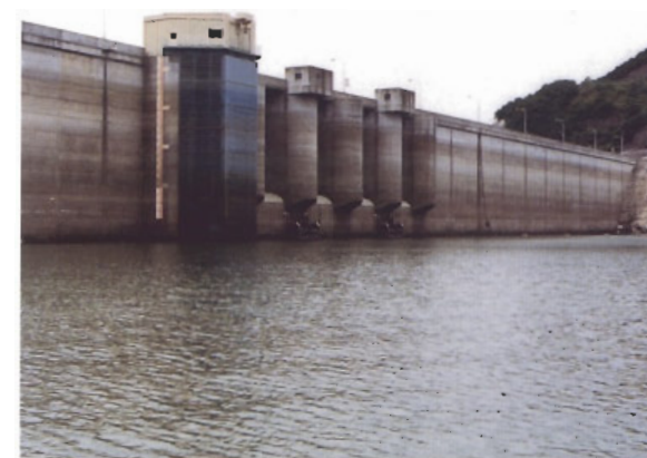
スクリーンの形状がピアの形状と異なり、違和感がある。
