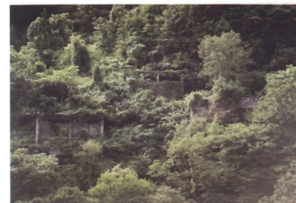
放置されたままの仮設備。植物も侵入できないでいる。
