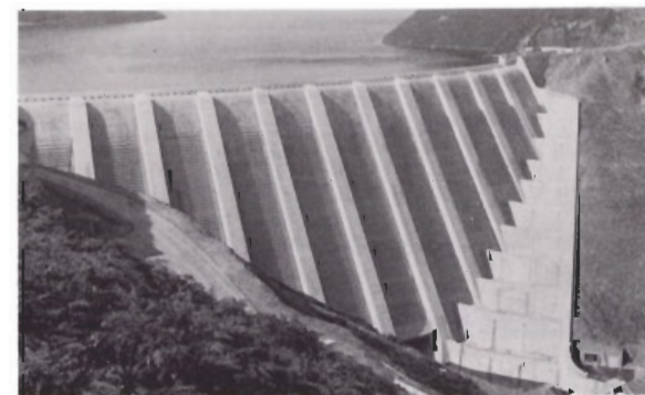
〔CLYWEDOG DAM (ENGLAND)〕 巨大なフーチングであるが、各段の高さをダム本体のデザインのピッチに合わせており、すっきりと仕上がっている。
