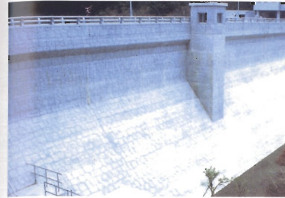
(座間味ダム：沖縄県) 下流表面に化粧型枠を用いて適度な変化を与えている。
