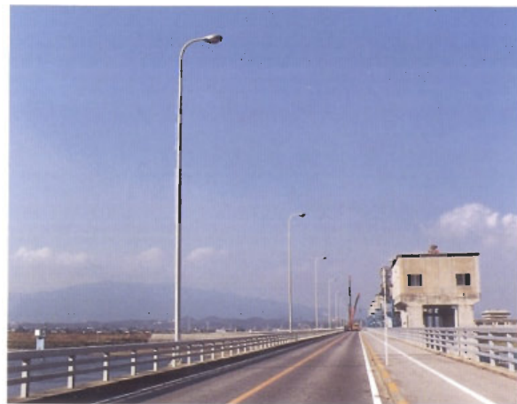
(筑後大堰：水資源開発公団) 照明設備を規則的に配置することにより、視線を誘導する効果がある。また、高欄と材質が同一であること、デザインがシンプルであることなど、まとまりのある景観をつくりだしている。
