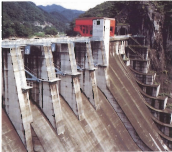
〔蕨原ダム：建設省・関東地方建設局〕 フーチング部とダム本体とを曲線によってすりつけている例。本体下流表面との連続性を強め、違和感をやわらげている。
