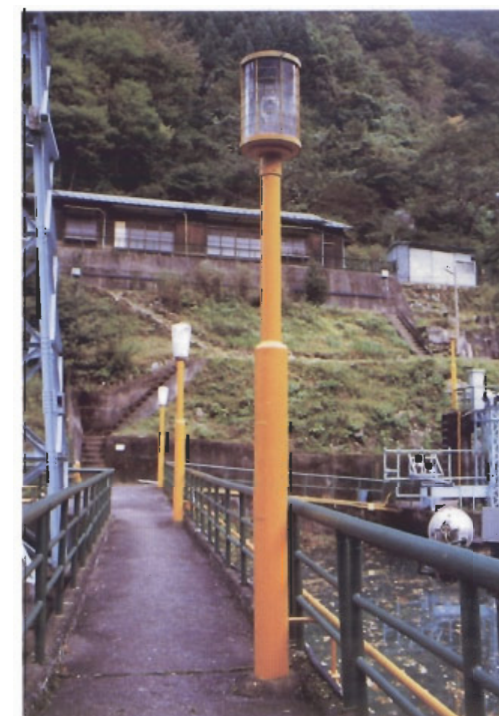
照明設備、高欄、取水設備等の配色に統一感が欠けている。
