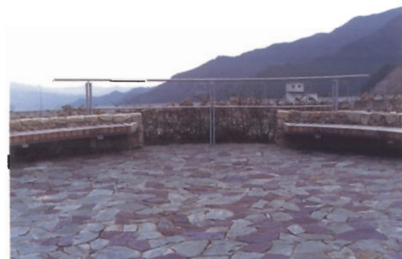
〔磨木ダム：建設省・九州地方建設局〕 石張りの舗装で、自然的なやさしさがある。
