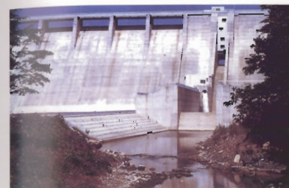
(佐幌ダム：北海道) 常用洪水吐の導流壁が目立ちにくいため、下流表面と導流面とが連続して見える。
