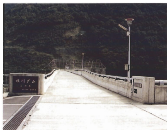
照明設備に付属機器や補助照明灯が付けられ、シンプルな外観を損なっている。
