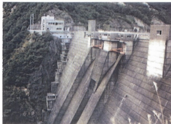
フーチング部のステップが一段ごとに高さが不揃いで、また形状も異なっており、違和感がある。
