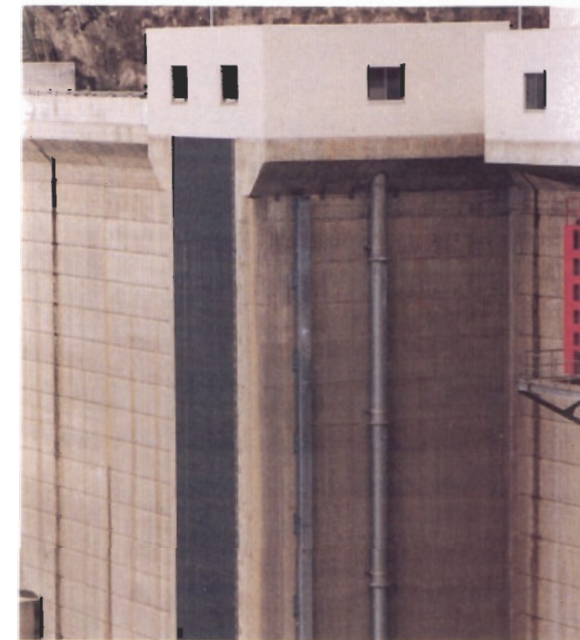
(山口ダム：福島県) 取水設備を可能な限りコンクリートで囲っており、材質の違和感を抑えている。
