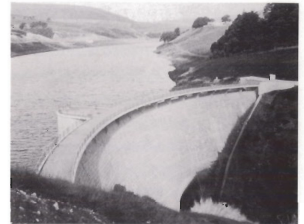
〔CASTLEHILL DAM (ENGLAND)〕 ダム軸のラインを曲線にしたアーチダラビティダム。取水塔の天端のバルコニーが視点場となっている。
