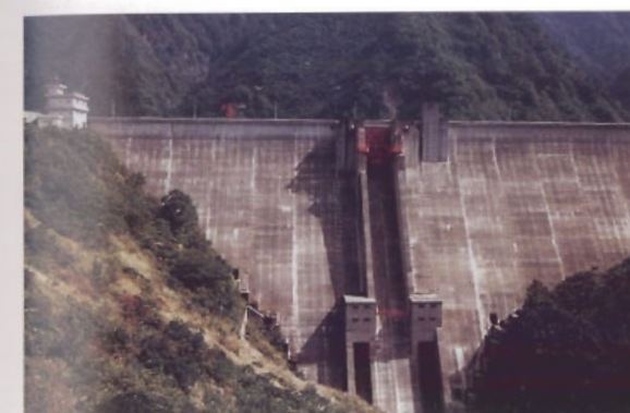
(加治川治水ダム：新潟県) 常用洪水吐が低い位置にあるため、導流面の汚れの発生が抑えられている。
