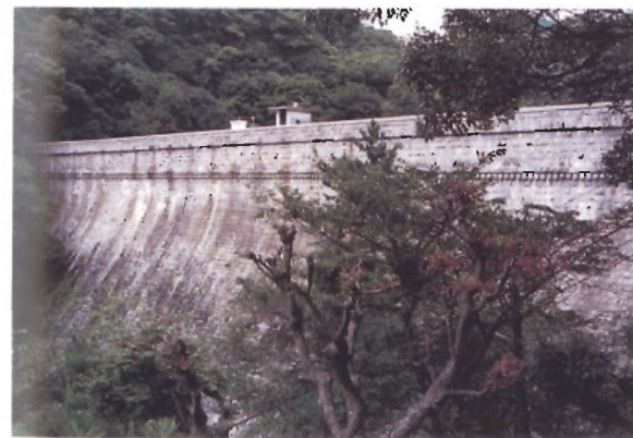
(五本松ダム：兵庫県神戸市) 古い石張りのダムであるが、重量感があり、周囲の自然にも調和している。
