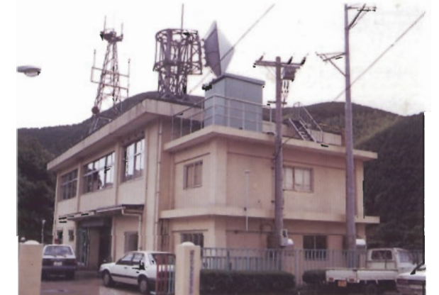
通信用鉄塔等の部材が錯綜し、全体を複雑なものに見せている。
