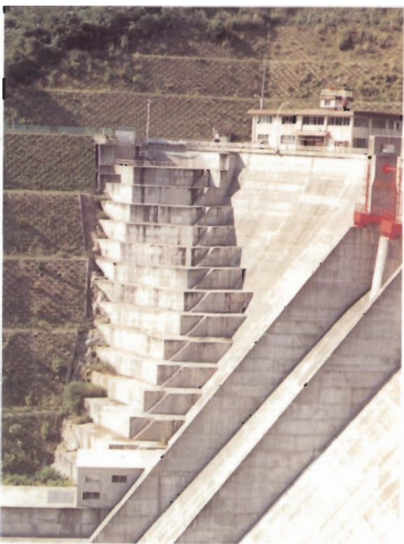
〔岩島ダム：秋田県〕 掘削法面に緑化工を施している。
