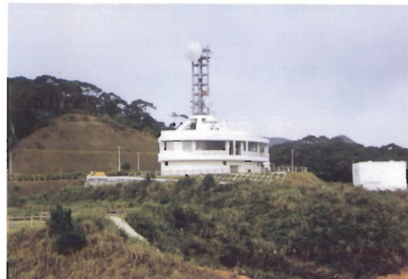
〔辺野喜ダム：沖縄開発庁・沖縄総合事務局〕 建物のデザインが丸みを帯びてすっきりとした仕上がりとなっており、かつ鉄塔もシンプルで、バラボラが感じのよいアクセントとなっている。
