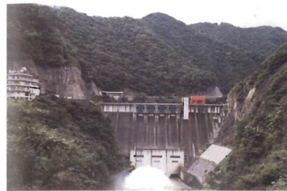
左岸側に設置されているエレベータの位置や規模が左右対称のバランスを乱している。吊り上げ設備等に対する配色に統一性がなく、また、周辺との調和に欠けている。
