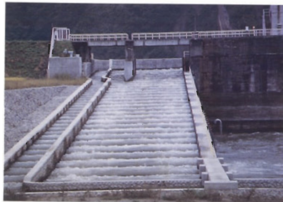
(宮中ダム：(旧)日本国有鉄道) 魚道も兼ねたカスケード状の放流により、景観演出効果が生み出されている。
