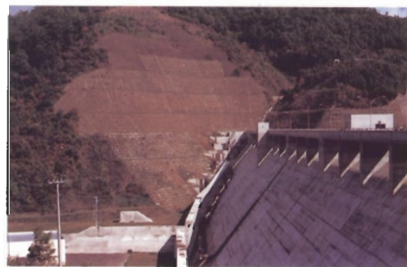
〔愛別ダム：北海道〕 同じく法枠工と緑化工により、草本が芽を吹き出してきた法面。
