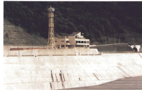
〔浅瀬石川ダム：建設省・東北地方建設局〕 建物の突出物が少なく、また配色も同系色に統一され、やわらかい感じを与えている。
