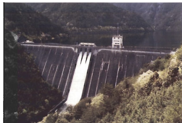
ダム堤体全体のおさまりは良いが、ダム天端の付帯設備がダムのシルエットを乱している。
