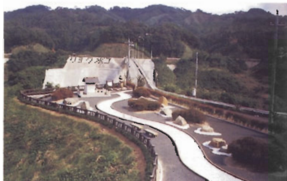
〔賀祥ダム：鳥取県〕 歩道部分とそれ以外の部分とを色分けし、庭石等によりアクセントをつけている。
