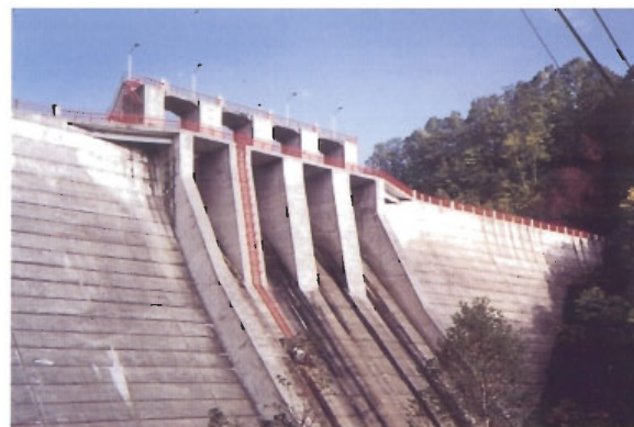
(雨龍第一ダム：北海道電力株) 縦目地に加え、横目地も強調されている。
