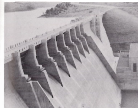
〔CENTER HILL DAM (U.S.A.)〕 ゲートピアを直立させず、丸みをつけて、やわらかさをだしている。
