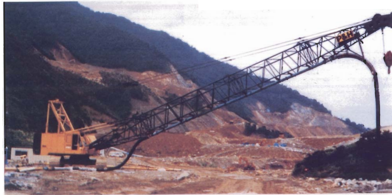
昭和59年度試験施工状況（クレーン配管圧送試験）
