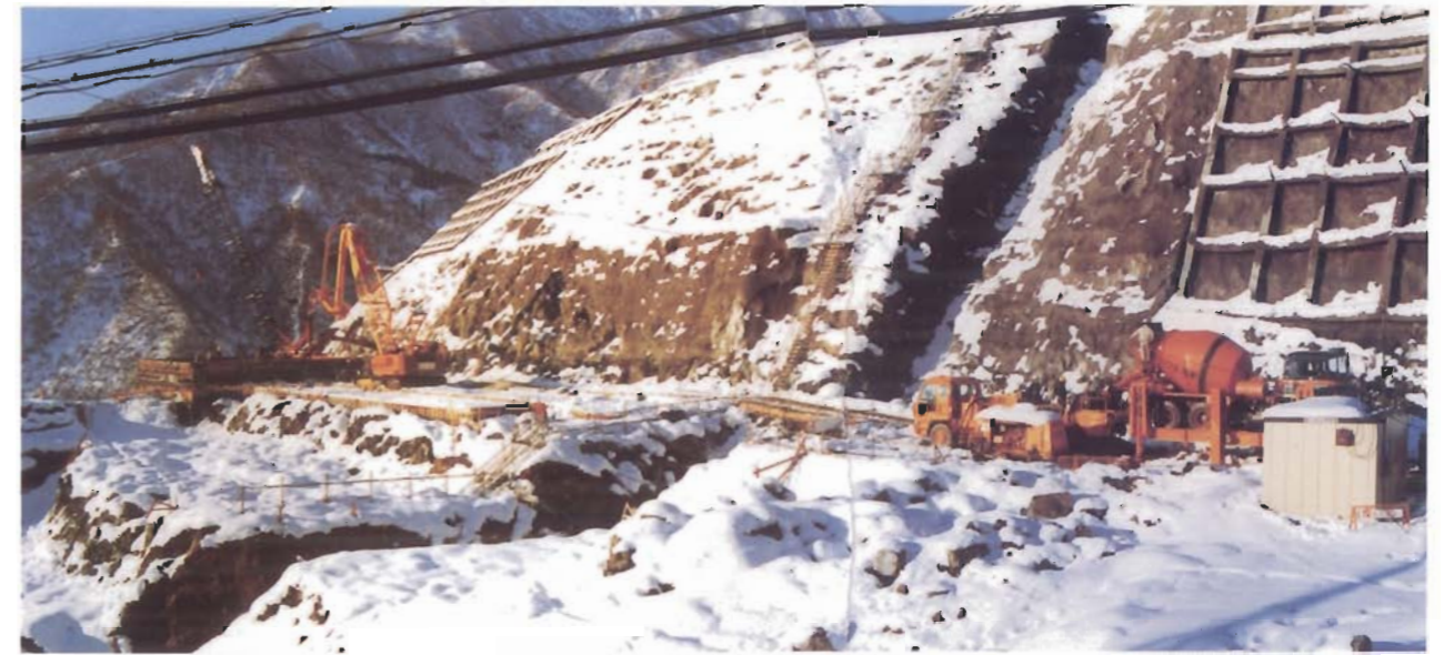
実機圧送試験（約50mの外部配管を設置した）
