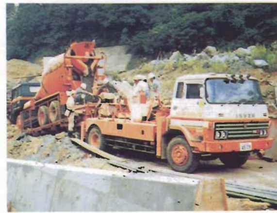
（コンクリートポンプ車投入）
