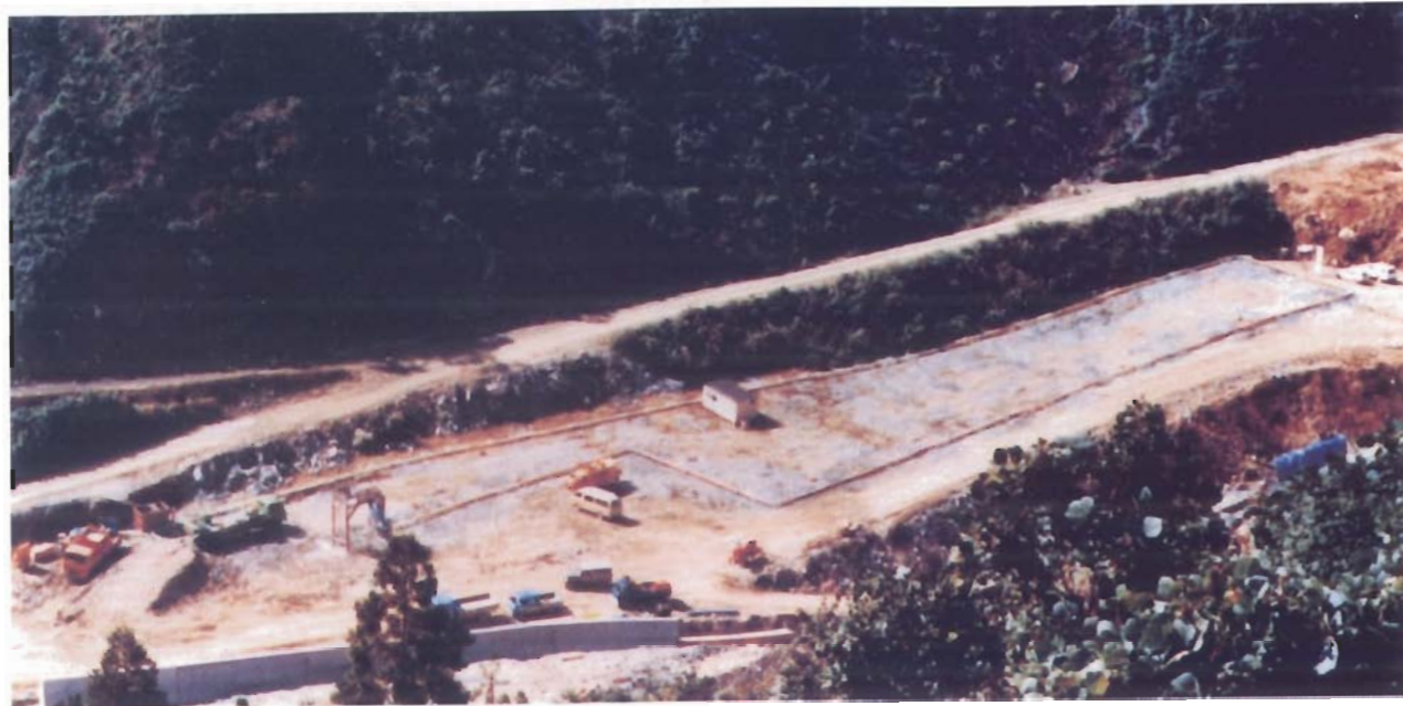
昭和59年度試験施工状況（300m水平配管圧送試験）
