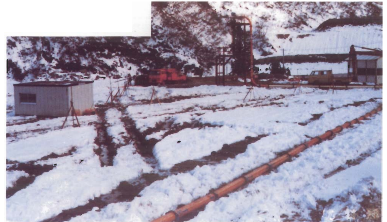
昭和58年度試験施工状況（300m水平配管圧送試験）
