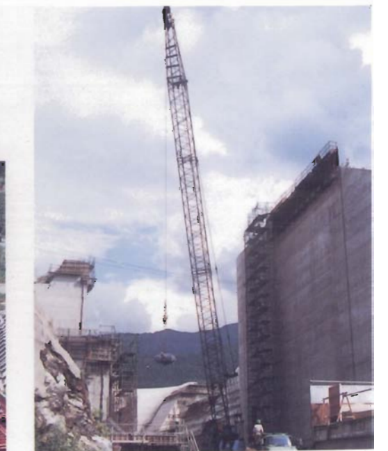
40tクローラークレーン
