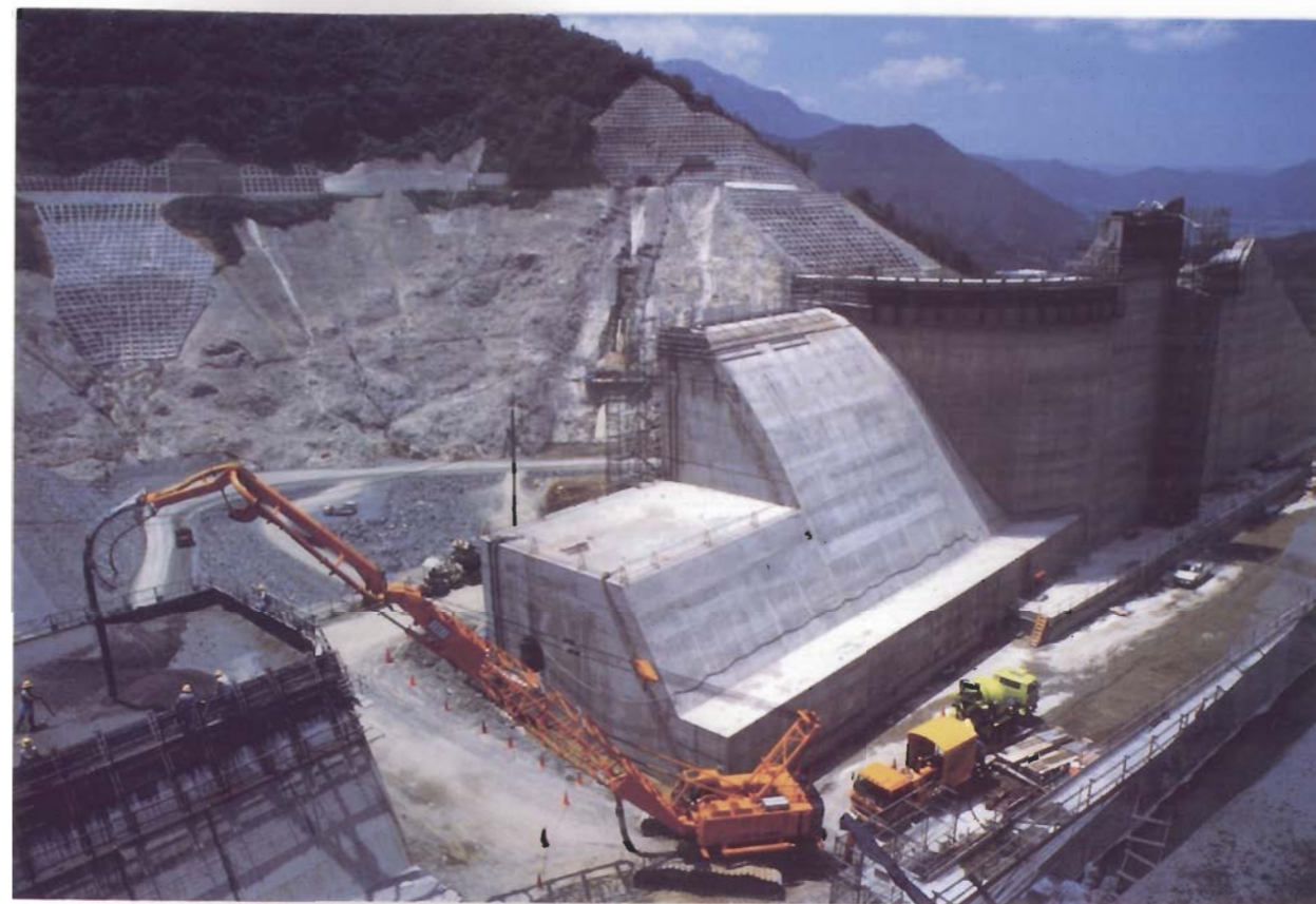
63年度流入部（3BL堤体側導流壁）
