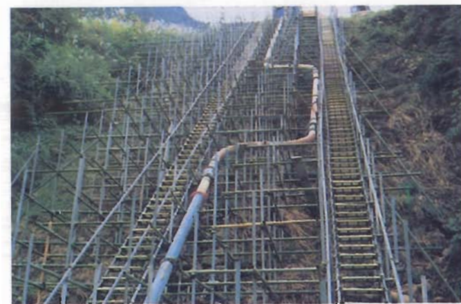
（ディストリビュータ配管圧送試験）
