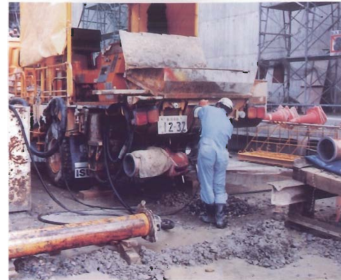
圧送管に高圧水ホースが接続されている。
