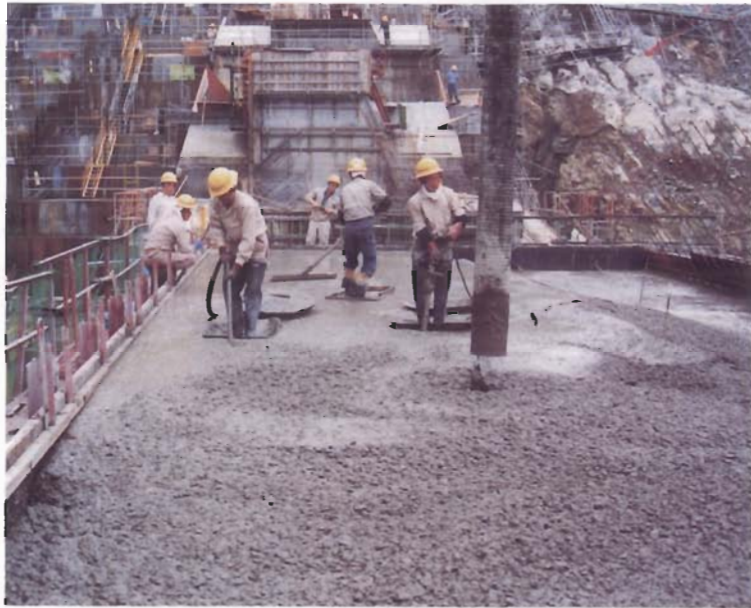
人力締固め状況
