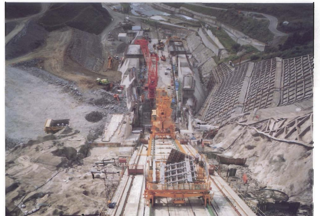
導流部減勢部の状況（昭和63年9月撮影）
