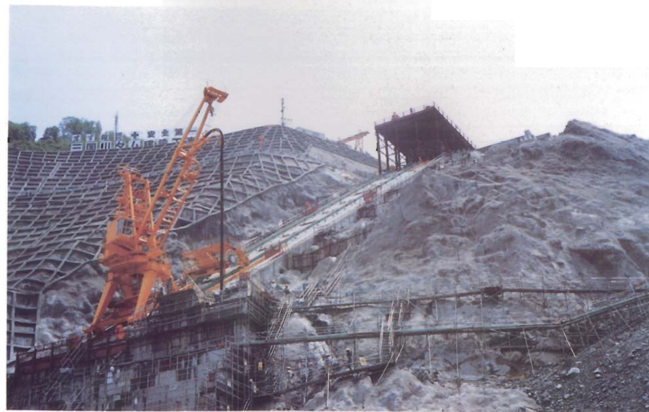
63年度導流部（19BL堤体側導流壁）
