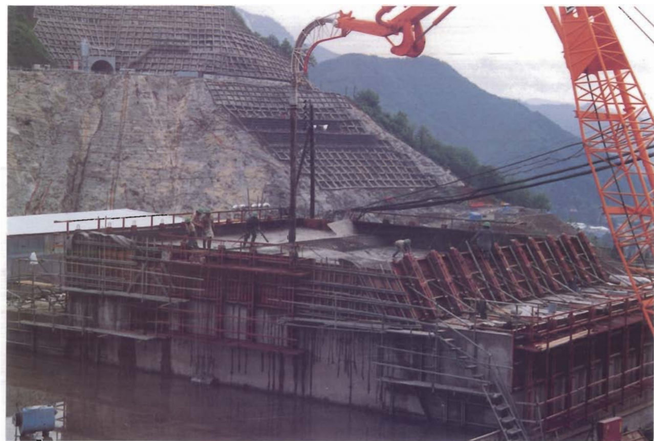
62年度流入部（5BL堤体側導流壁）
