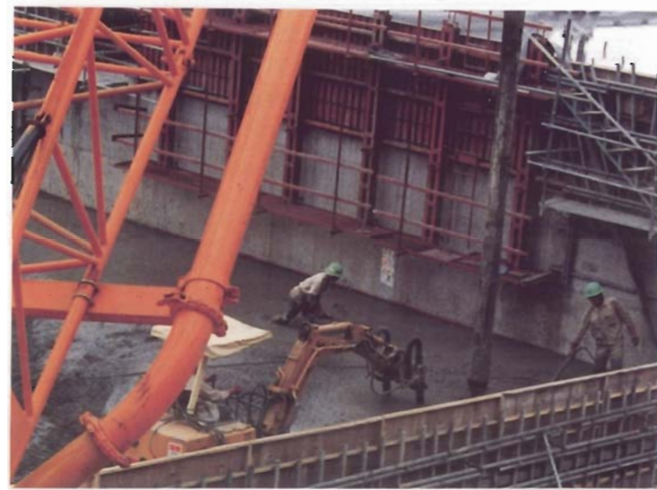
小型バイバック締固め状況
