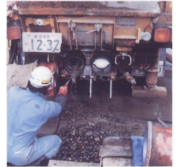
ポンプ機構内部はポンプ車に搭載された高圧ジェット水で水洗いする。
