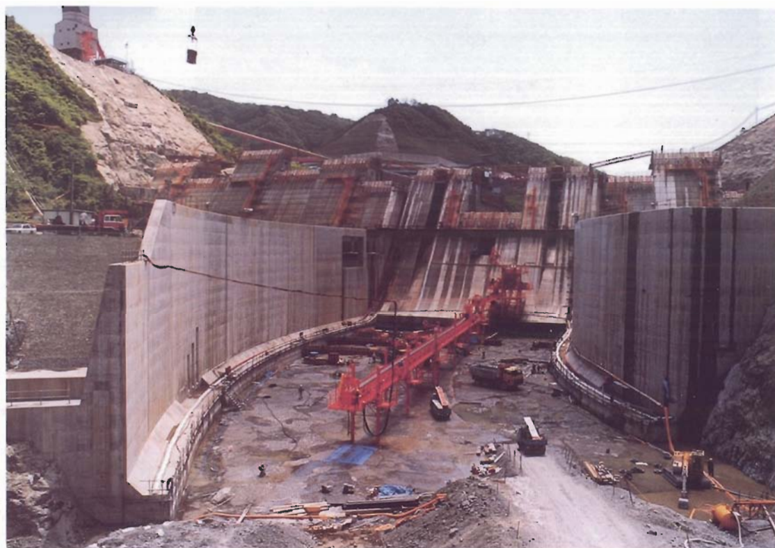
減勢工水叩部コンクリート打設全景
