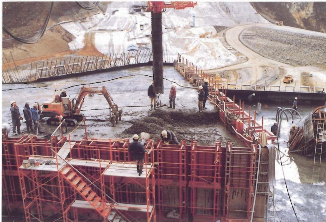
小型バイバック締固め状況
