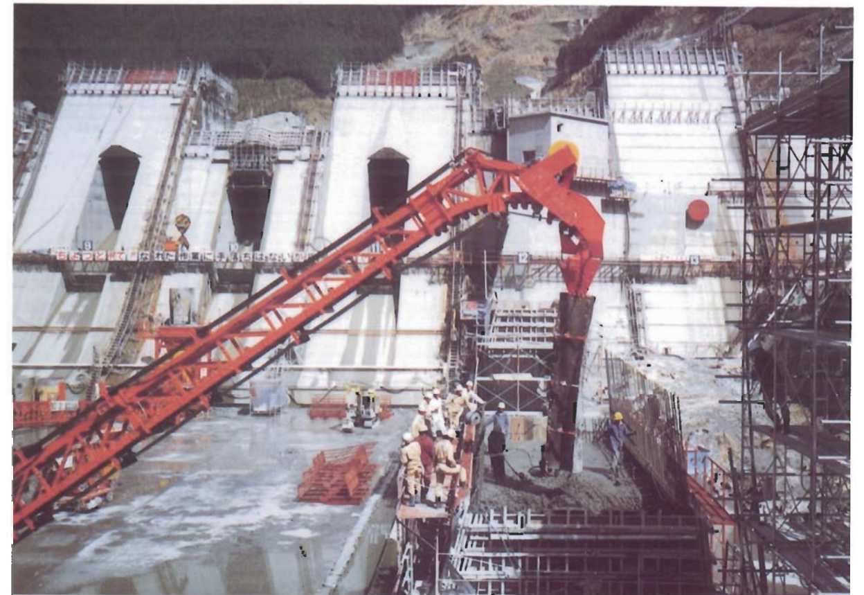
打設コンベヤによる コンクリート打設
