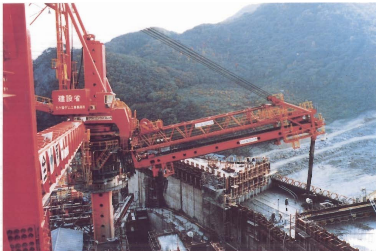
流入部コンクリート打設状況
