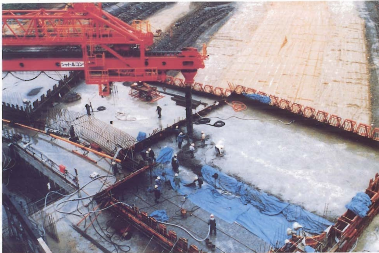
固定式旋回クライミングスプレッドによるコンクリート打設
