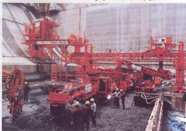
コンクリート打設
