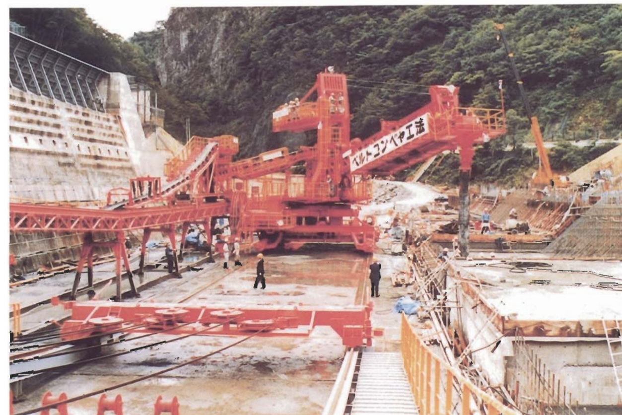
減勢部コンクリート打設状況
