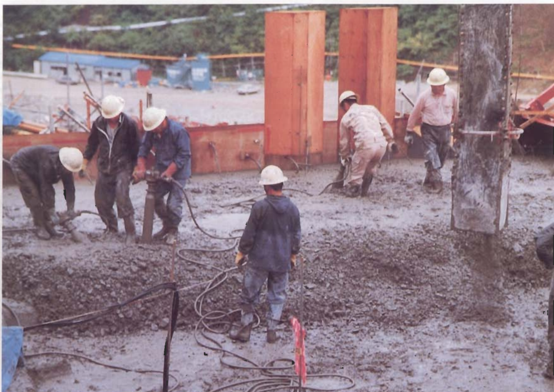
人力締固め状況
