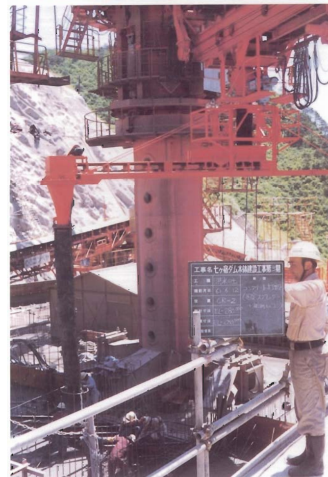
カバーエリヤ外の打設（補助打設コンベヤ使用）
