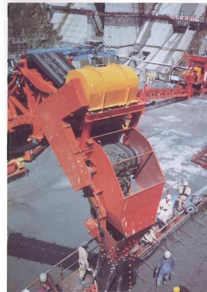
打設コンベヤ(抱込コンベヤ)先端部
