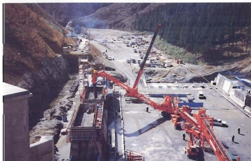
コンクリート打設
