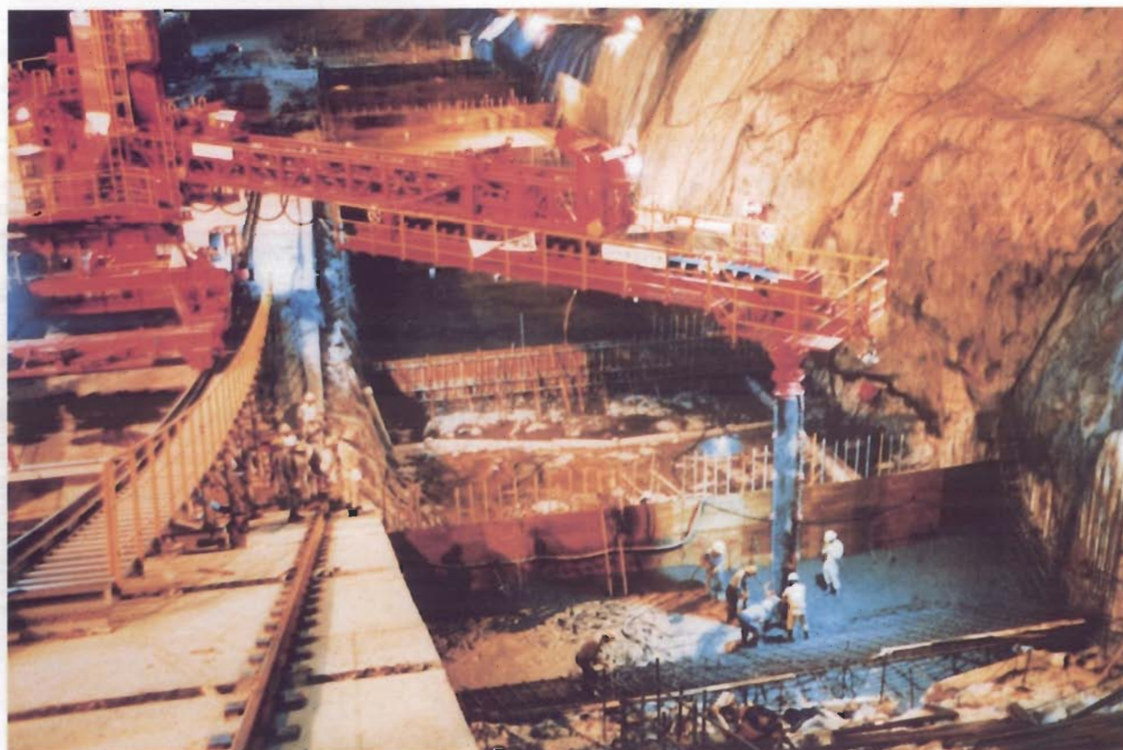
シュート部コンクリート打設状況
