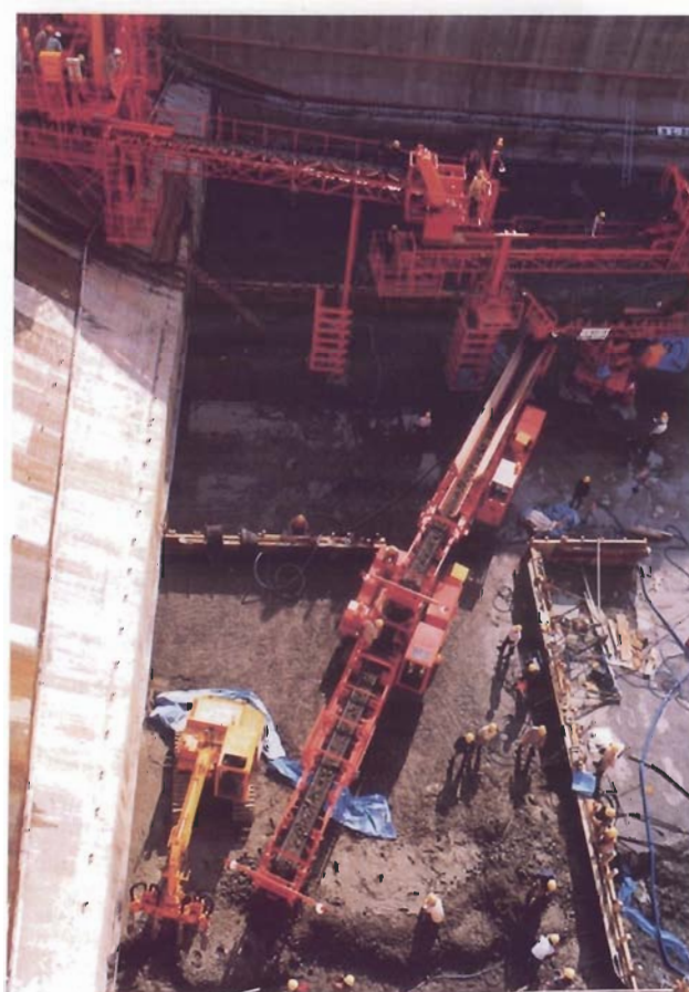
コンクリート打設
