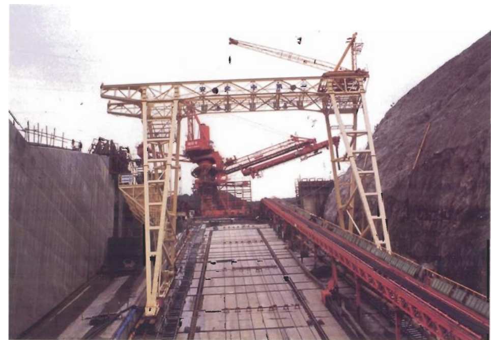
シュート部雑運搬作業クレーン
