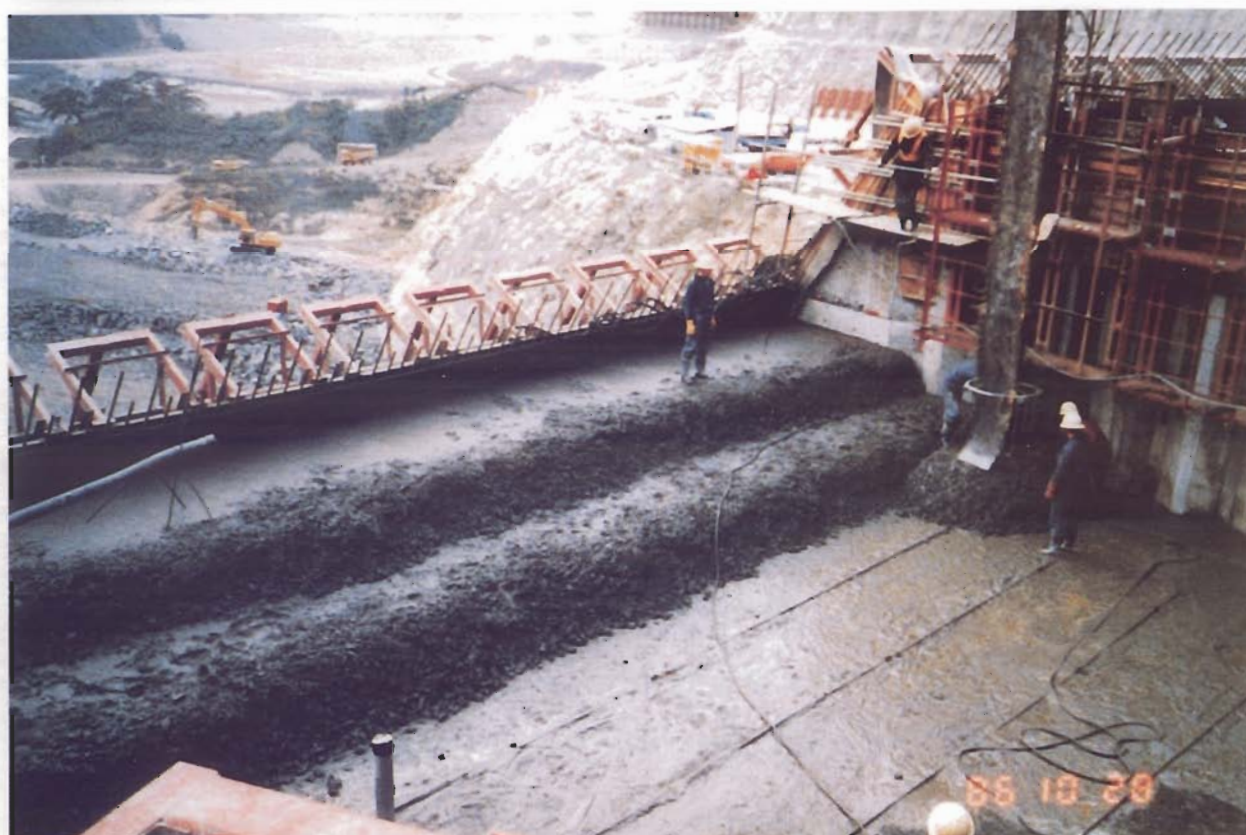
コンクリート打設状況
