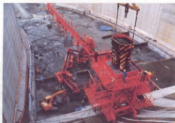
ケーブルクレーンによるコンクリート投入
