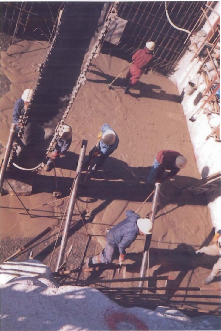
モルタル敷均し状況
