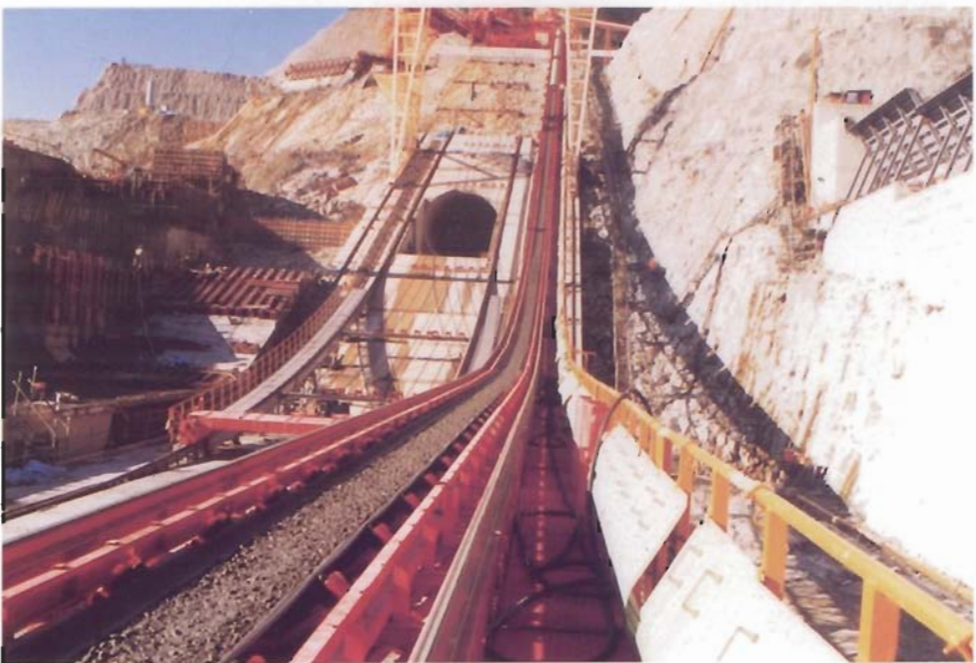
下り23°勾配コンクリート運搬状況
