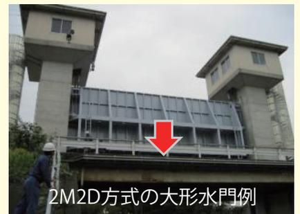
小形水門で実証した遠隔自重閉鎖システムの基本構成をもとに、大形水門用に既存の速度制御装置や左右同調制御装置等を組合せ、大形水門の自重閉鎖システムを構築
