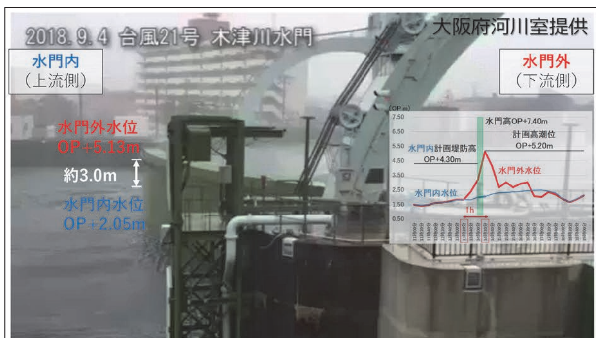
図 3.1-1 台風 21 号襲来時の木津川水門の閉鎖状況
