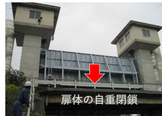
2M2D方式の大型水門例
