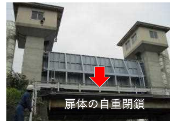
2M2D方式の大型水門例
