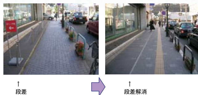
図-4 沿道と歩道の段差を解消した例
