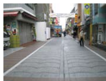
図-5 中央排水により沿道との段差を解消した例
