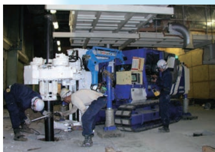
高さ2.1mの超短尺施工機械
