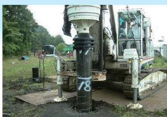
施工状況（φ406.4の施工）
