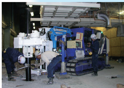
高さ2.1mの超短尺施工機械
