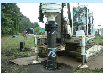
施工状況（φ406.4の施工）
