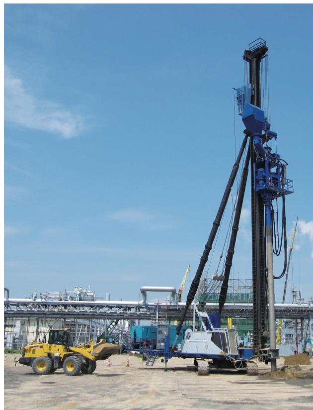
SDP-N工法の施工機械全景
