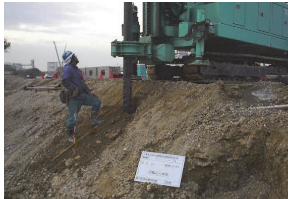
斜面での施工
