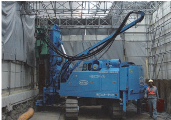
上空制限下での施工
