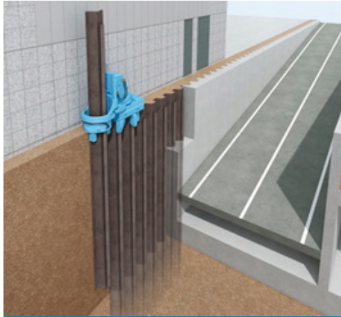
ビートルパイル打設イメージ
