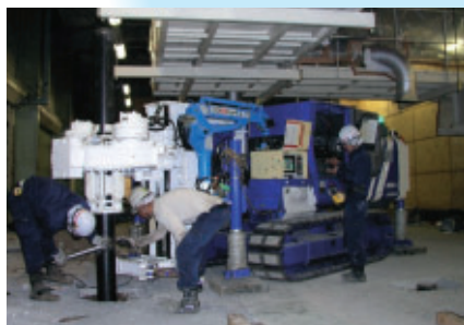
高さ2.1mの超短尺施工機械
