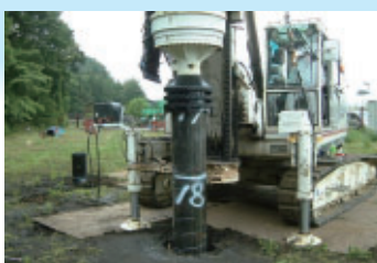
施工状況(φ406.4の施工)
