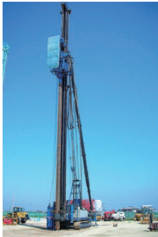
SDP-N工法の施工機械全景
