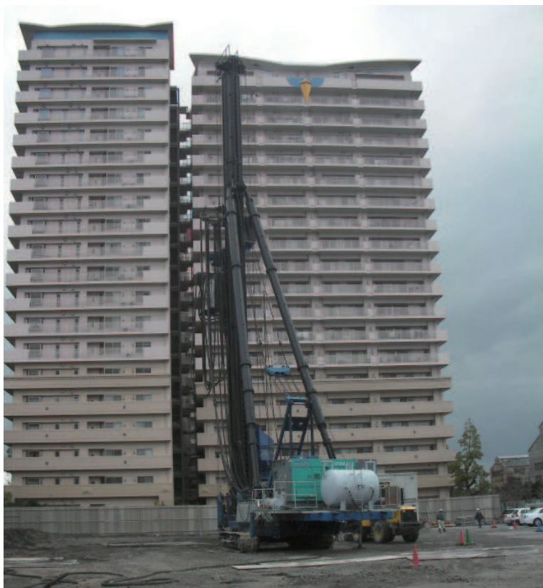
SDP-N工法の施工状況
