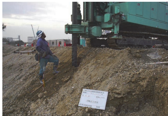
斜面での施工
