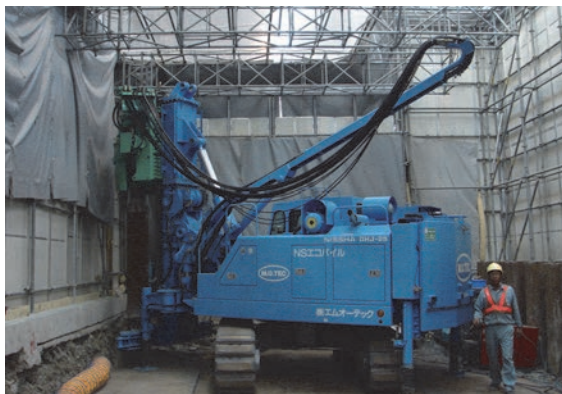
上空制限下での施工
