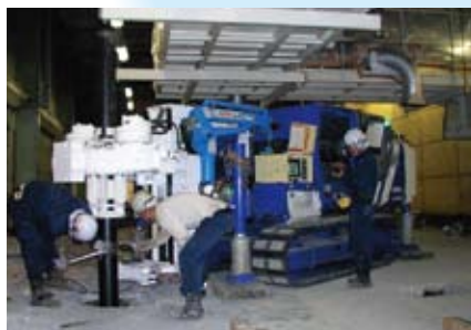
高さ2.1mの超短尺施工機械
