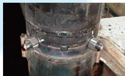
締付け完了状況
