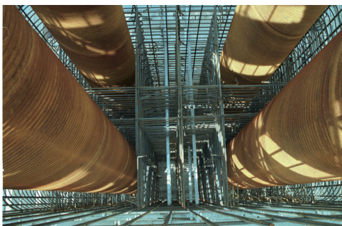
鋼管と鉄筋配置の例
