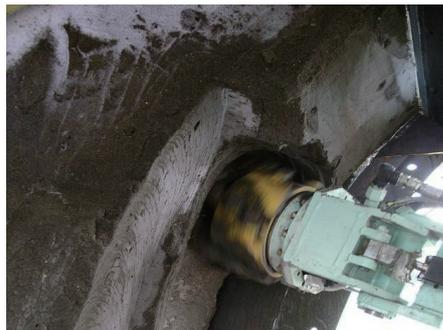
凍土の掘削状況(拡大)
