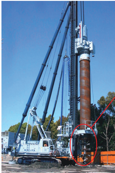
ガンテツパイル施工機・掘削攪拌翼
