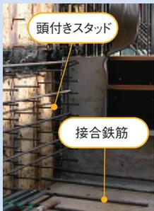
接合鉄筋の溶接施工例
