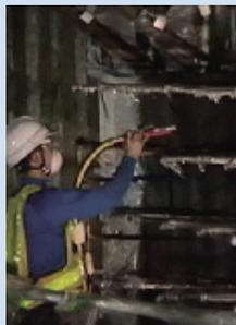
塗膜防水層の施工例
