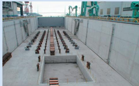
コンクリートを打設し、水張り後のドックの状況例
