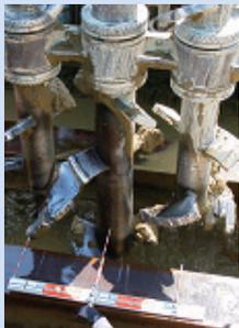
SMW施工機で削孔中の例
