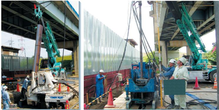
施工状況（左：鋼矢板圧入工 右：固化改良工）
