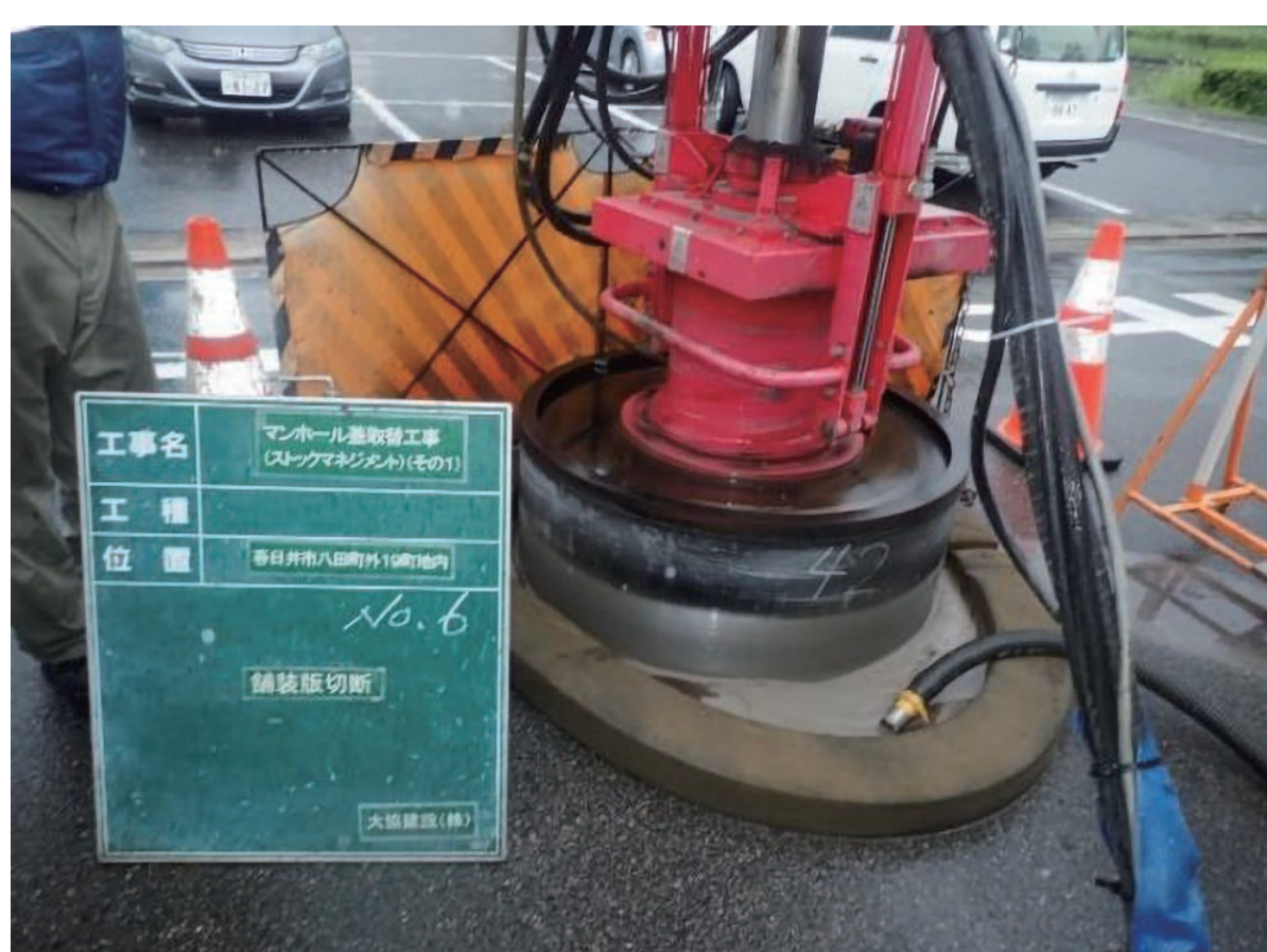
円形カッター切断状況
