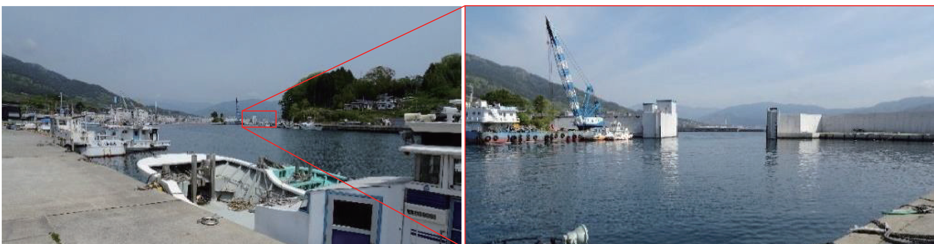
本技術施工完了後の漁港の様子
