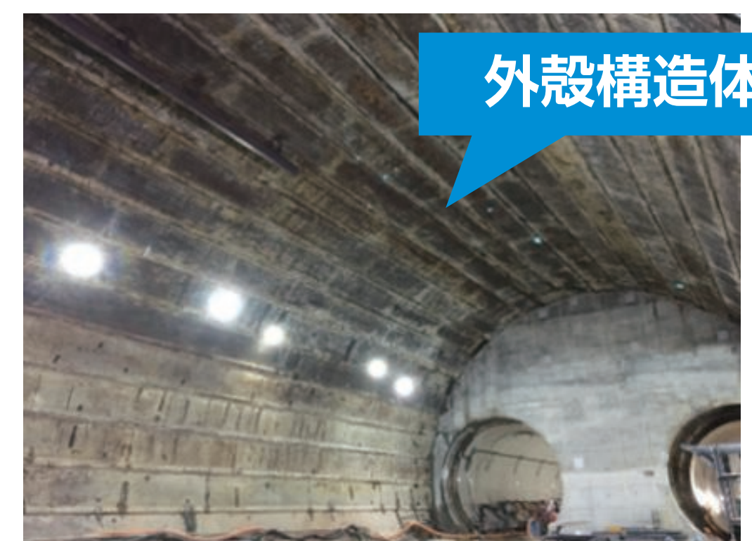
大断面トンネル構築状況
