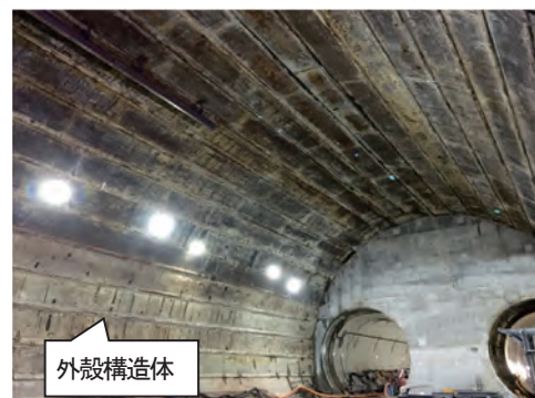
写真一 1 綱島トンネルにおける適用状況
