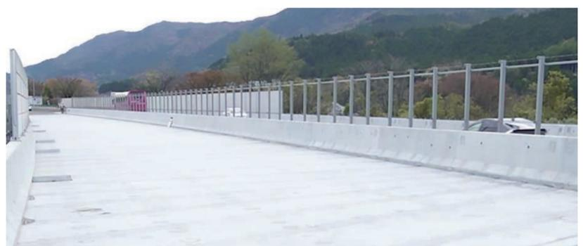
写真-4 UFC複合床版架設完了
