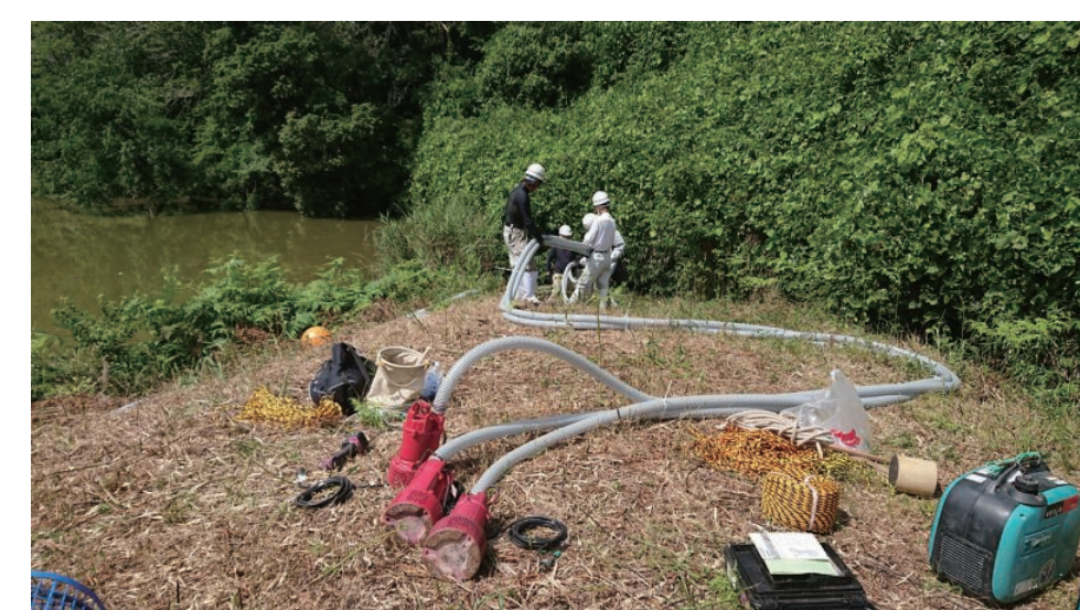
写真-2 全ての機材が人力で運搬可能
