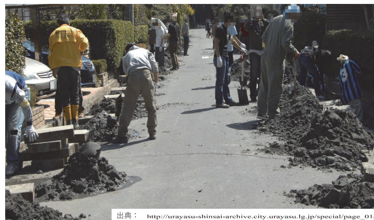
東日本大震災の住宅地液状化被害
