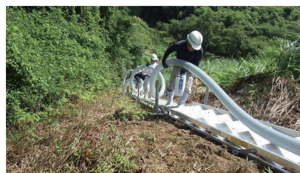
写真-1 人が通れるスペースで運搬
