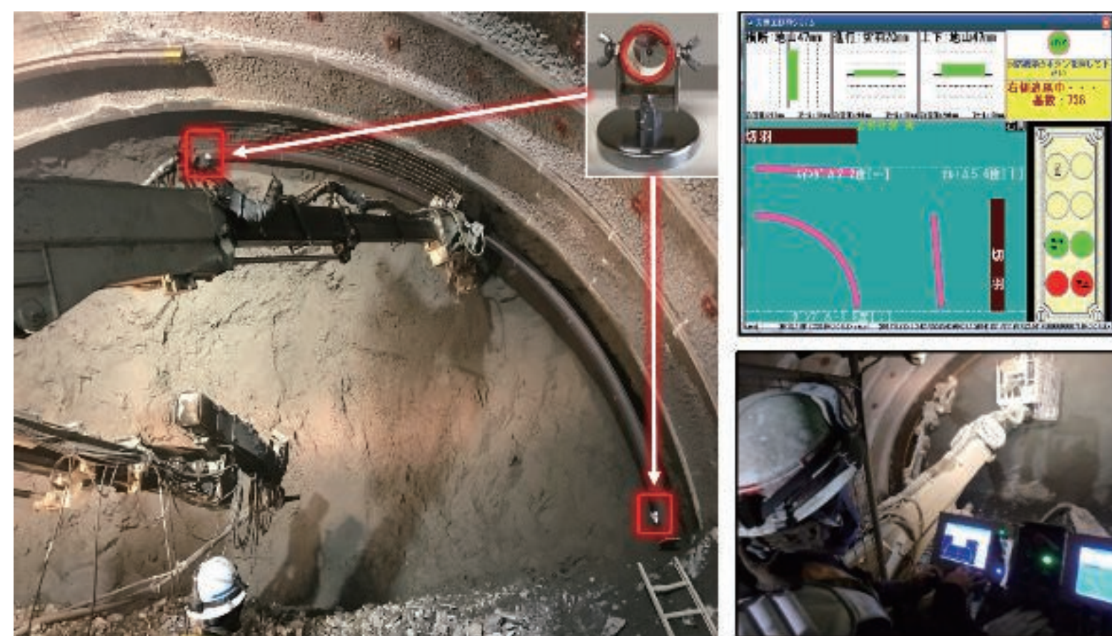
ナビによる鋼製支保工位置合わせ状況
