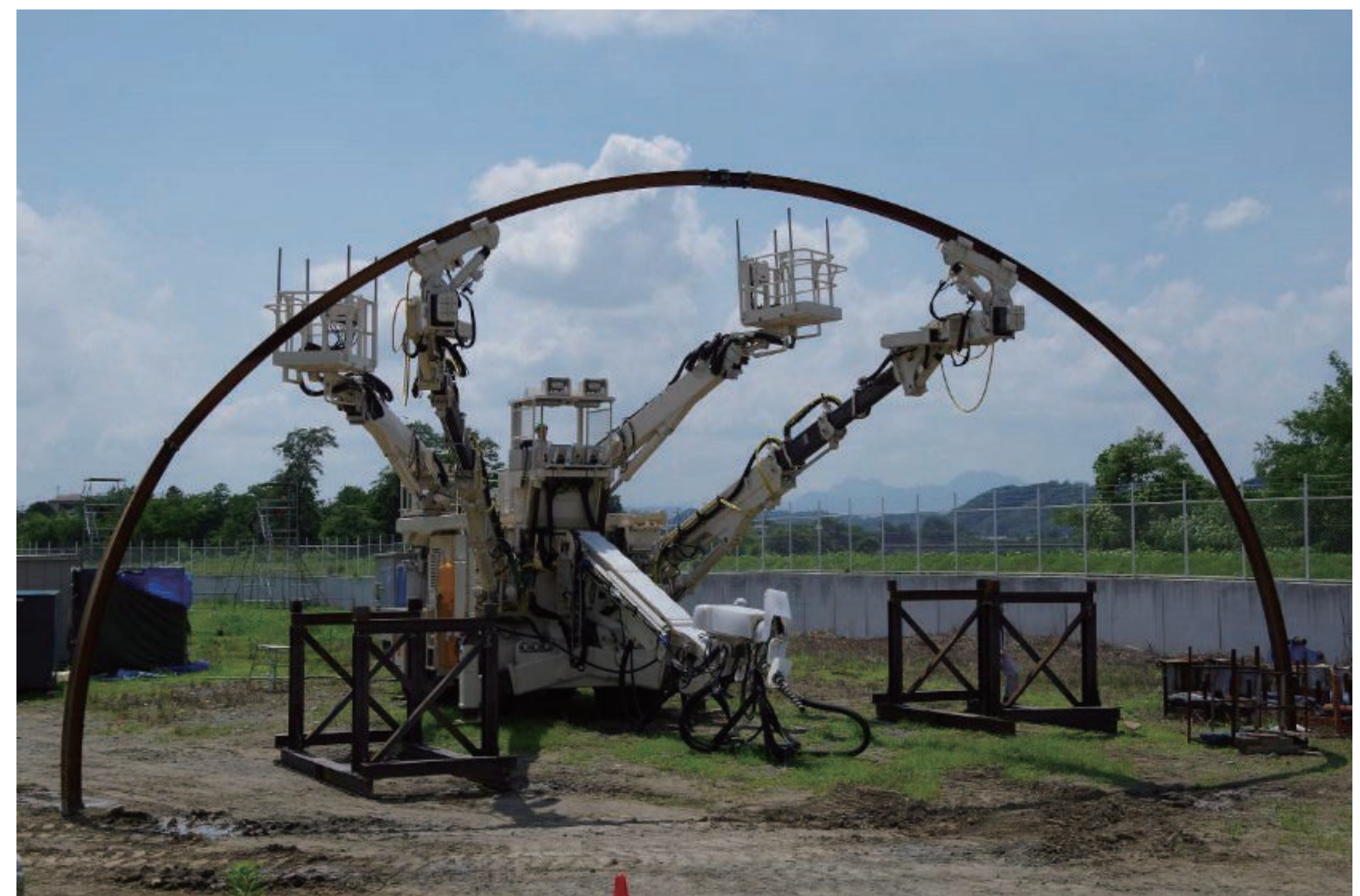
鋼製支保工建込みロボットの全景
