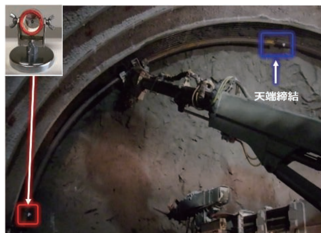
天端締結状況
