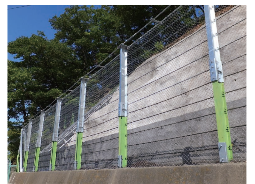
かさ上げ施工
