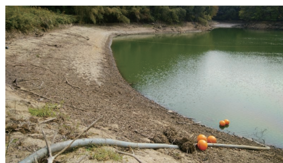
写真-3 1台でも膨大な水量を排水
