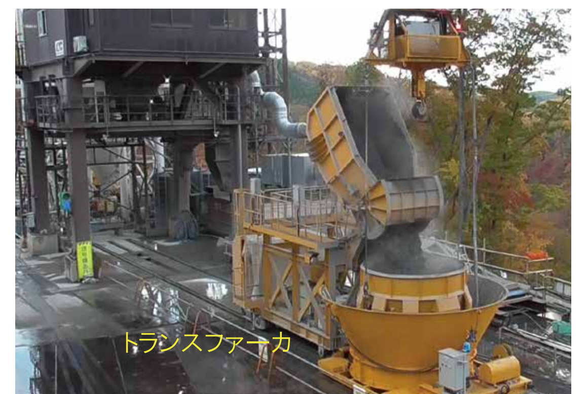
コンクリート運搬の自動化
