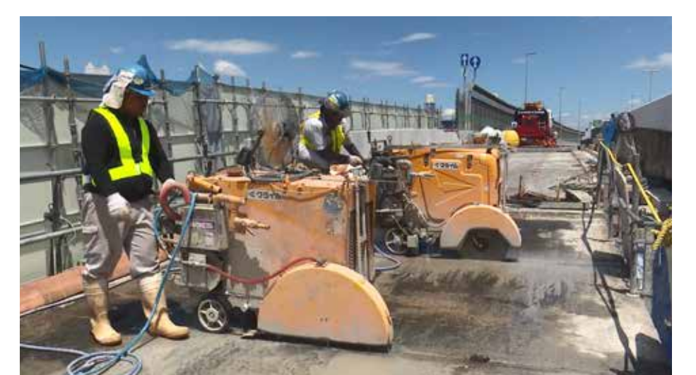
写真-5 コンクリートカッターでの切断
