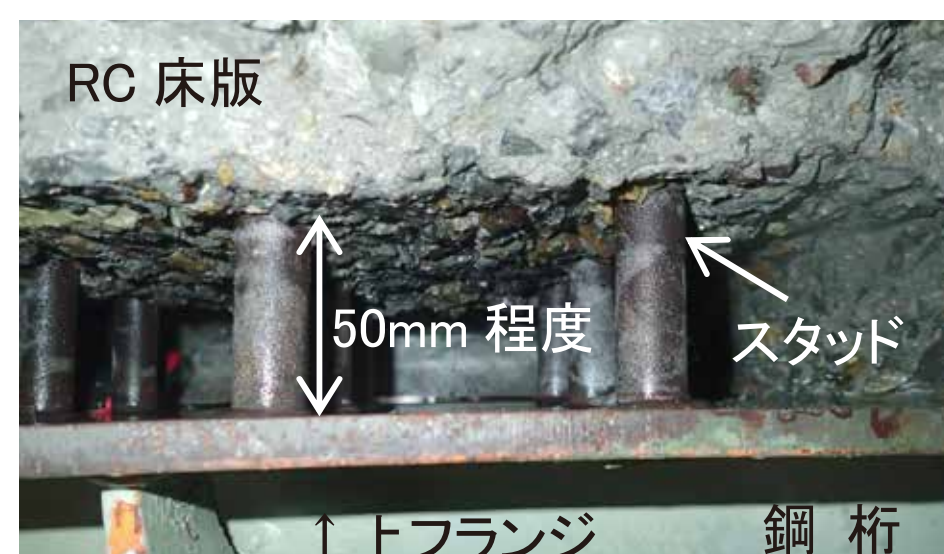
写真-2 接合部の除去状況
