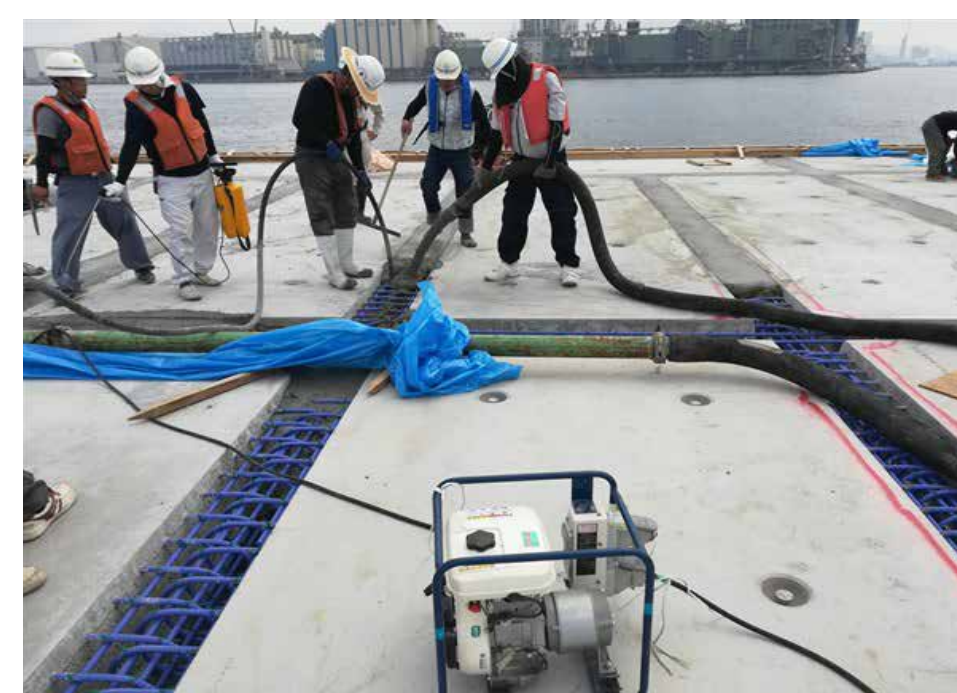
図-6 コンクリート打設状況
