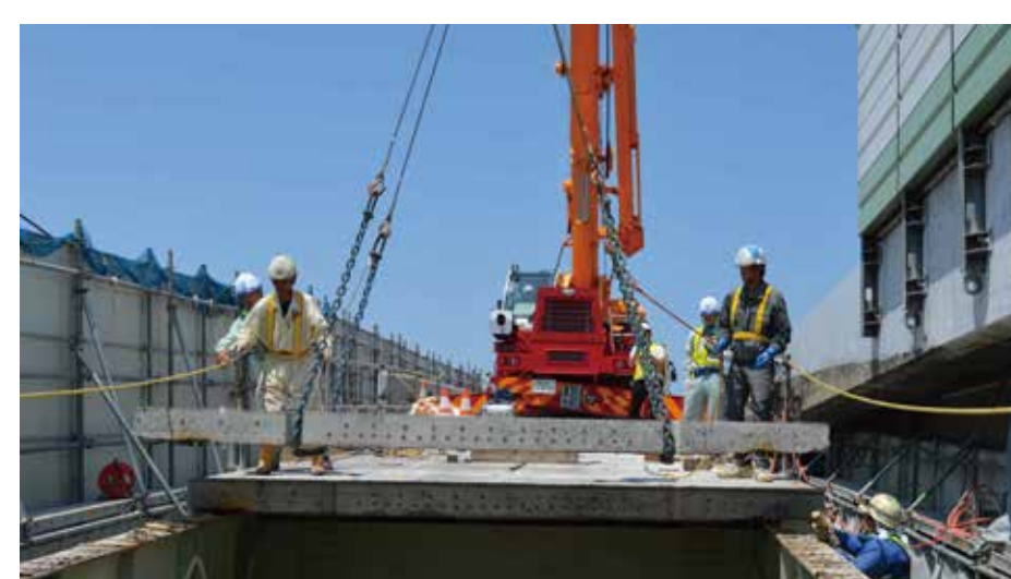
写真-4 床版撤去の状況
