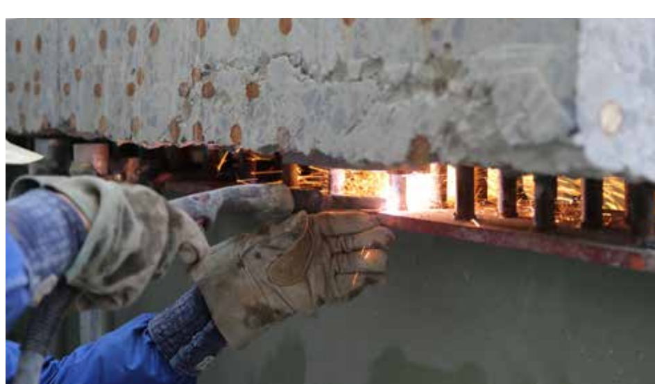
写真-3 ずれ止め（スタッド）の切断
