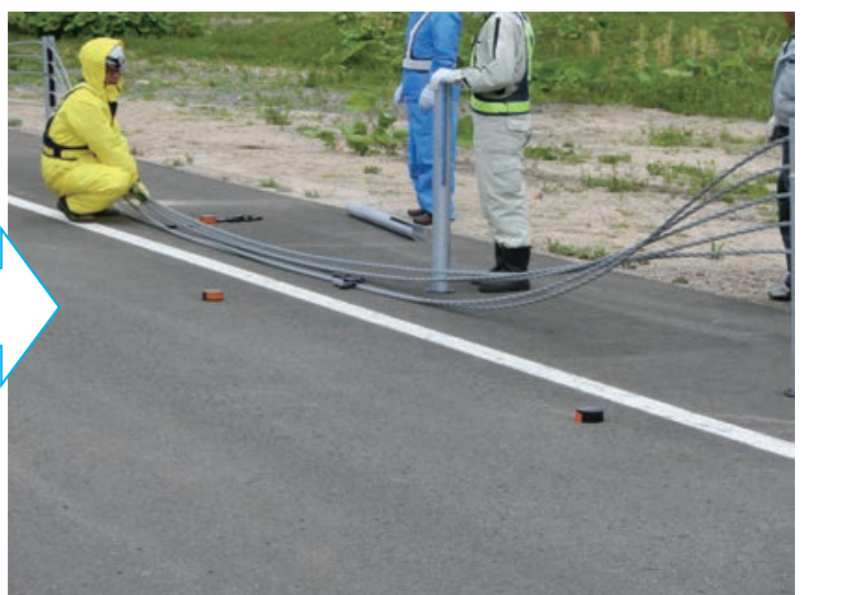
▲支柱は人力で脱着し、開口部を設置
