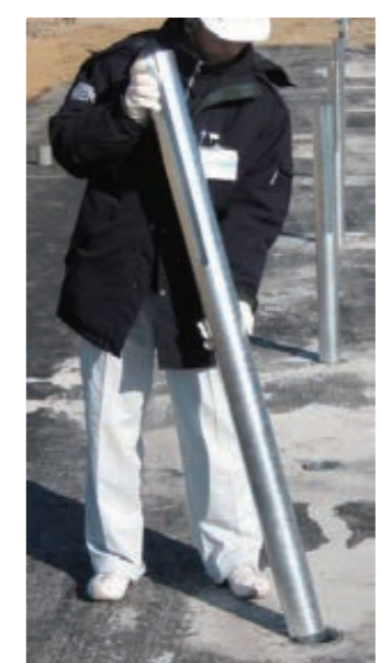
▲破損した支柱を取り外し、スリーブに挿入
