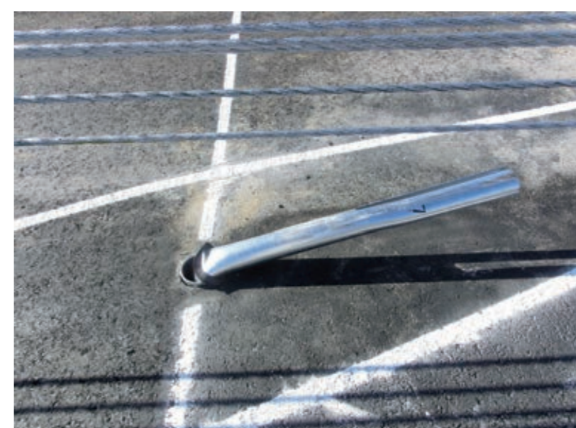
▲破損した支柱を取り外し、スリーブに挿入
