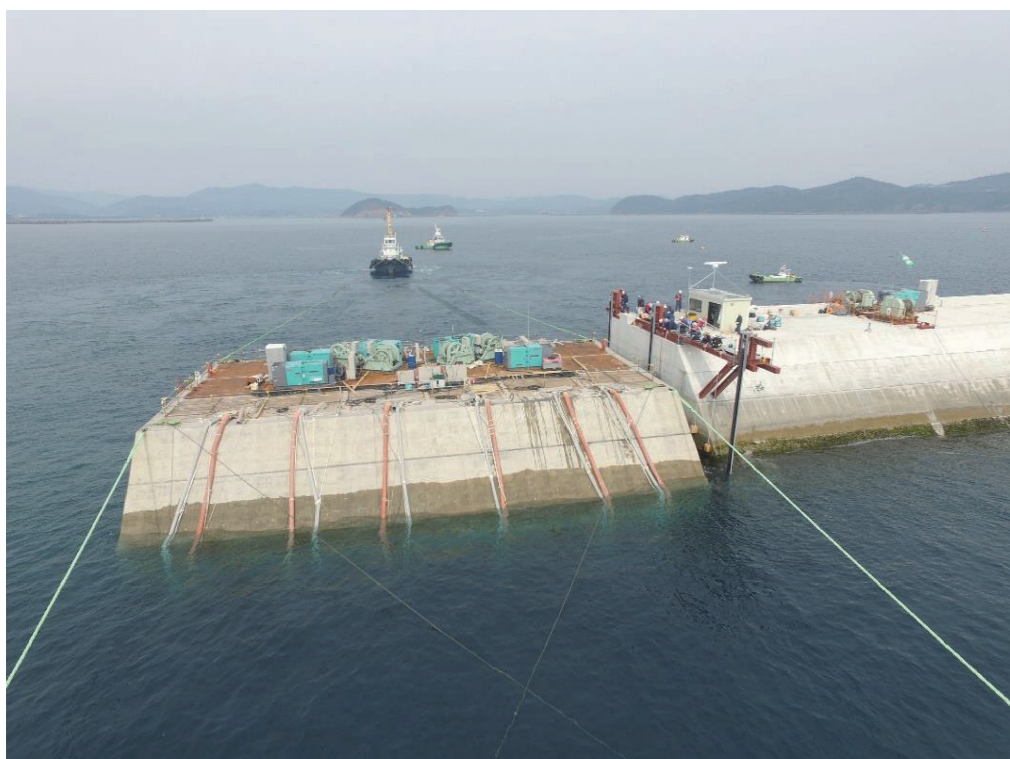
ケーソン自動据え付け制御システム稼働状況
