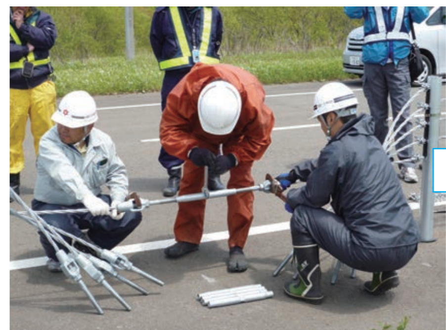
▲支柱は人力で脱着し、開口部を設置
