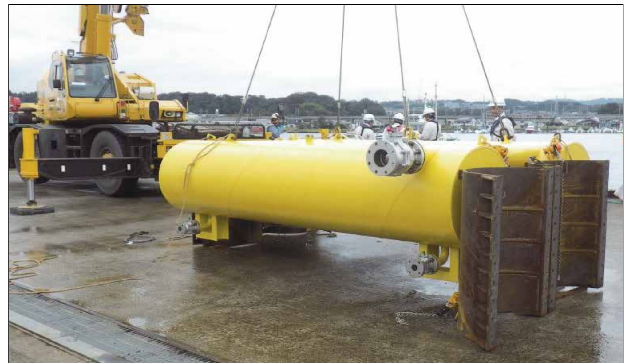
補剛部材に専用鋼製フローターを艀装
