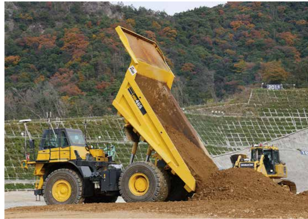
自動ダンプトラックと自動ブルドーザの連動
