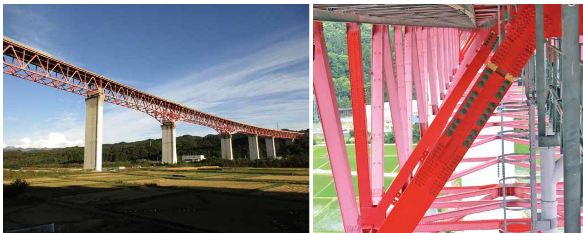
a) 橋梁全景
