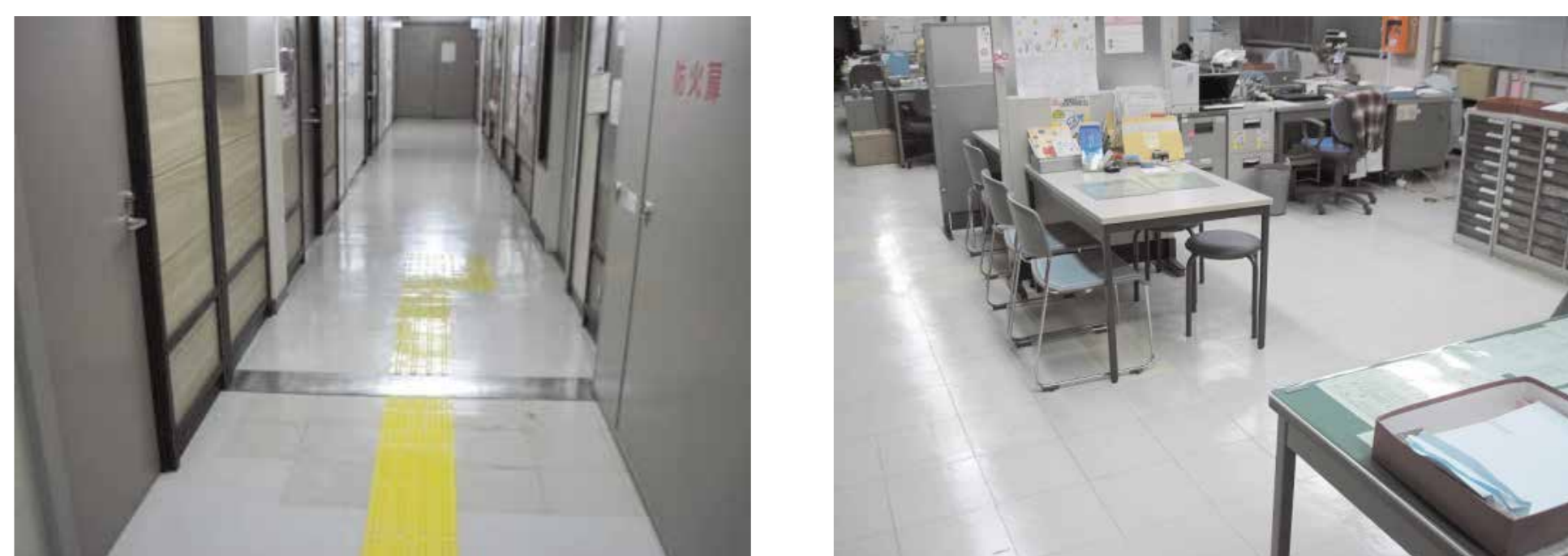
新潟県新発田地域振興局 1F廊下 施工日：平成26年3月 新潟県新発田地域振興局 1F執務室 施工日：平成28年3月
