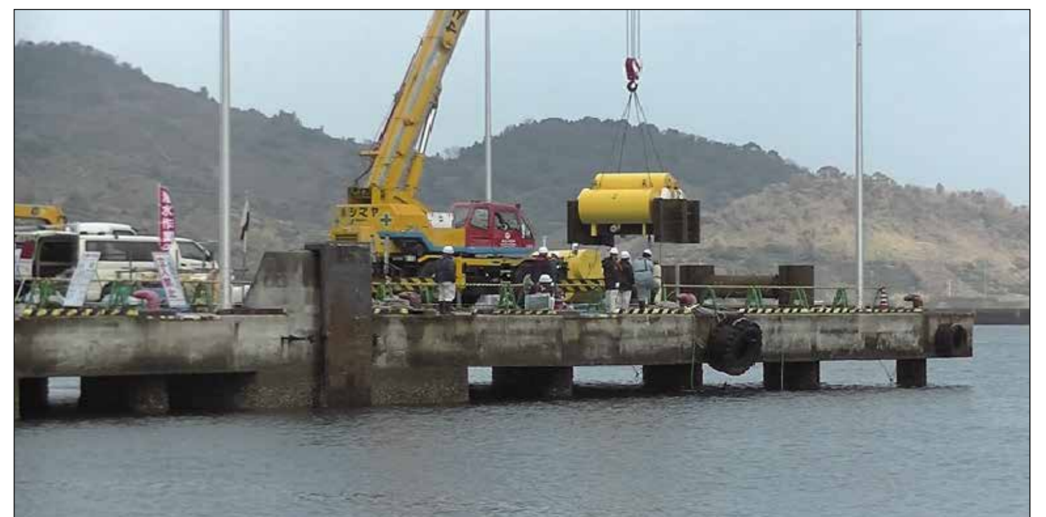
岸壁を供用しながらの施工
