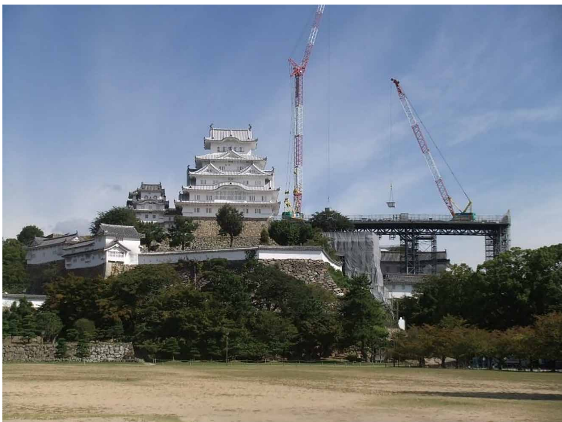
写真-2 素屋根解体工事完了
