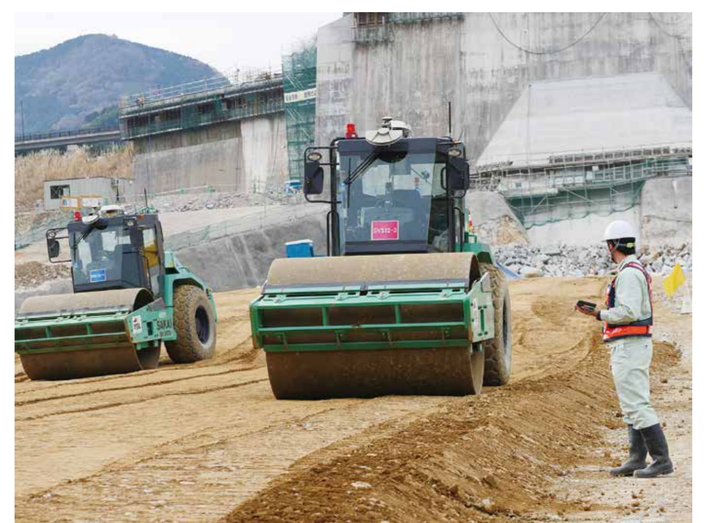
汎用の振動ローラに自動操舵装置・制御 PC 等を搭載
