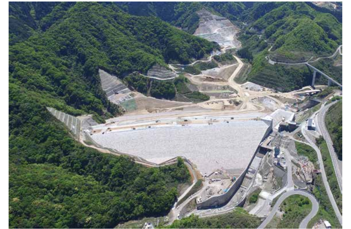
A 4 CSEL を適用した大分川ダム建設工事
