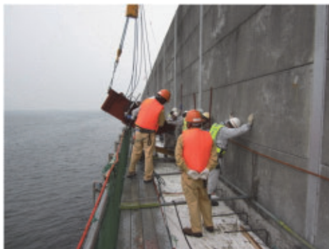
(a) ベッセルによる打込み
