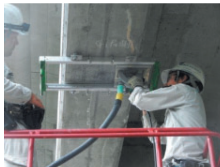
（写真－2）スリット切削状況
