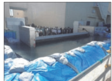
平成 27 年 10 月完成 撫養港海岸桑島瀬戸地区
