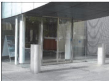
平成 25 年 5 月完成 ビルエントランス用
