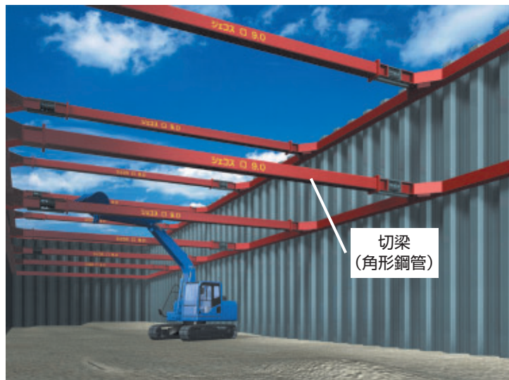
図-2 角形鋼管切梁による土留め工
