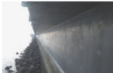
(c) 波返し部の施工完了
