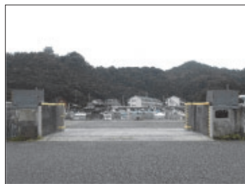
平成 26 年 4 月完成 徳島県日和佐港
