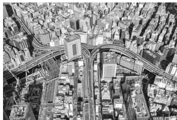
写真－1 都市内高速道路の例（江戸橋ジャンクション）
