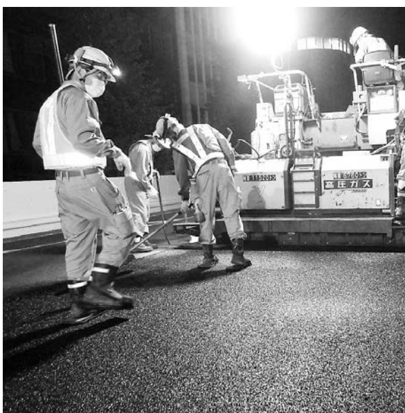
写真-4 高耐久超低騒音舗装施工状況
