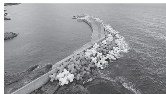
写真－６ 新設消波ブロック据付完了
