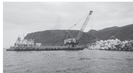
写真－５ 新設消波ブロック据付
